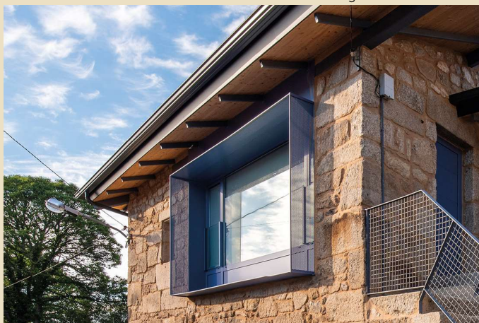
Imagen 2 Vista exterior ventanal cocina
