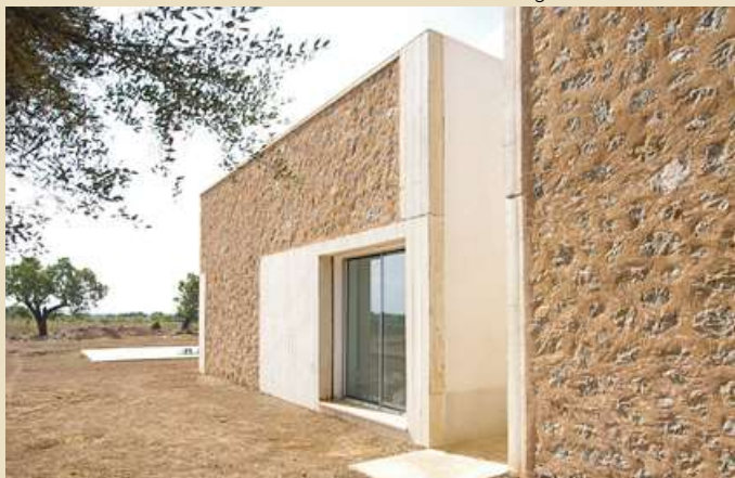
Imagen 2 Vista lateral exterior entrada a patio
