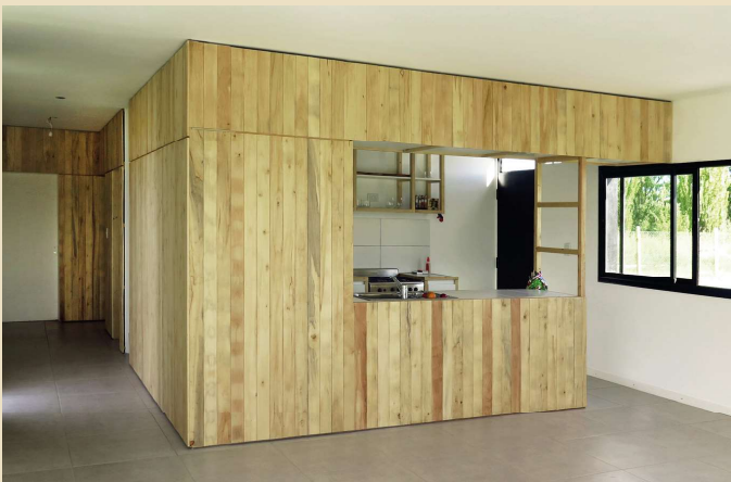
Imagen 2 Vista interior, cocina con revestimiento de madera de álamo
