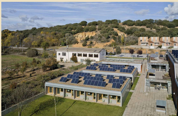
Imagen 2 Vista superior cubierta ajardinada y placas solares
