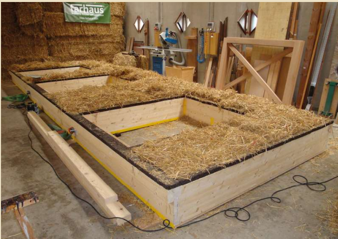
Imagen 2 Muros con interior de paja
