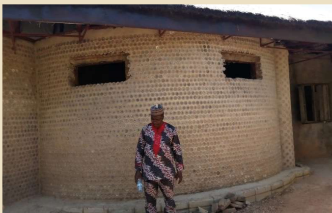
Imagen 2 Vista exterior de la vivienda
