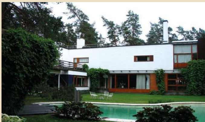
Imagen 2 Vista desde el patio trasero
