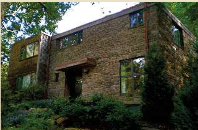
Imagen 3 Vista exterior fachada principal
