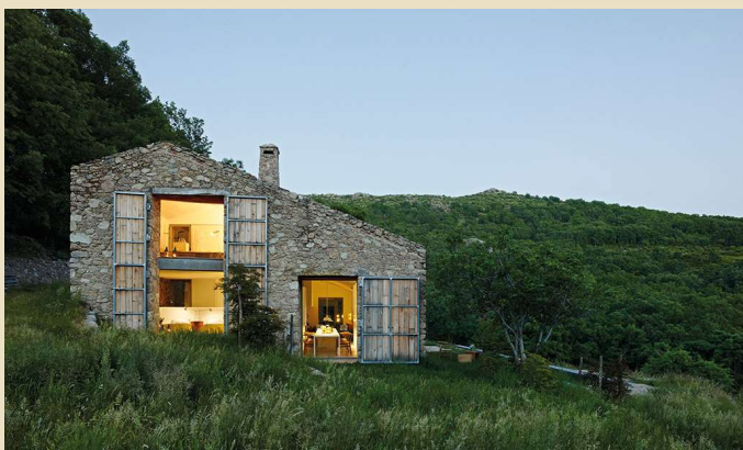
Imagen 2 Vista lateral iluminación artificial
