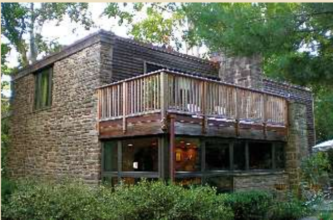
Imagen 1 Vista exterior parte trasera
