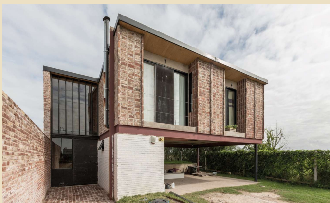
Imagen 1 Vista exterior fachada principal
