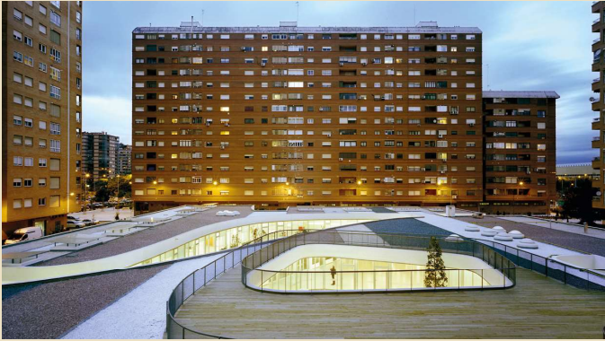
Imagen 1 Vista exterior nocturna
