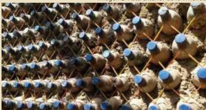
Imagen 3 Botellas colocadas con cuerda y barro
