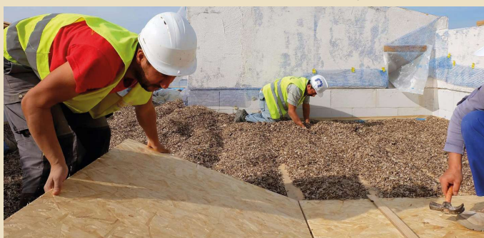
Imagen 4 Colocación de las algas en cubierta
