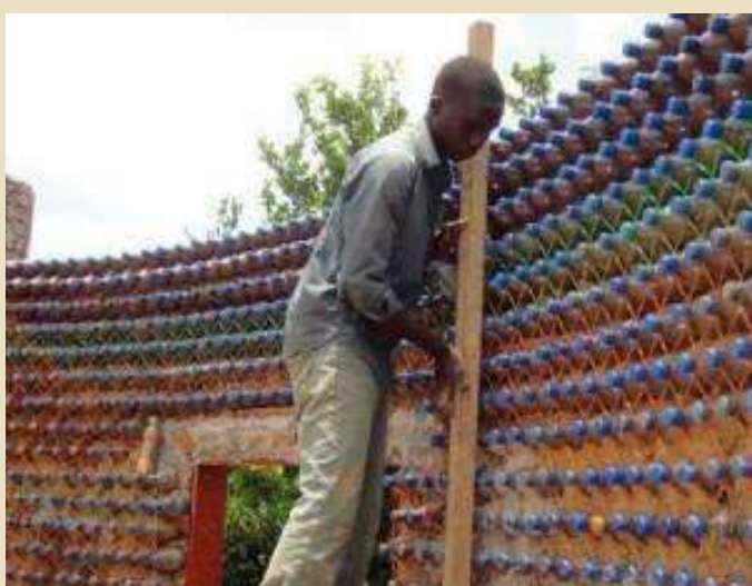
Imagen 1 Colocación de las botellas de plástico
