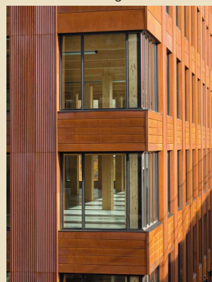
Imagen 3 Detalle Revestimiento exterior
