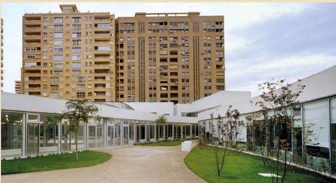
Imagen 2 Vista patio interior
