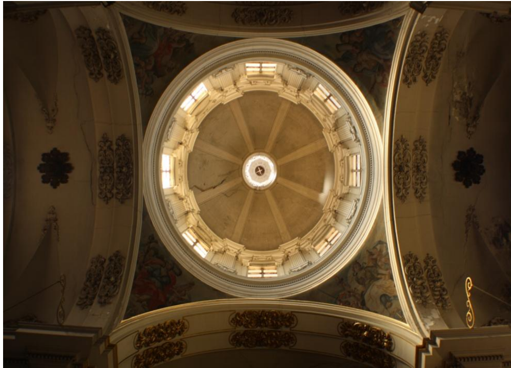
19. Vista general de la cúpula
