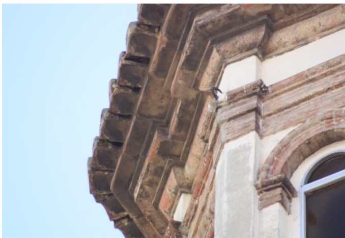
33. Detalle cornisa linterna
