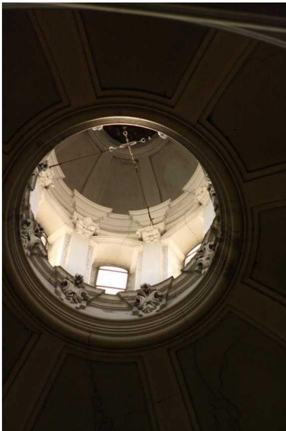
22. Detalle linterna cúpula
