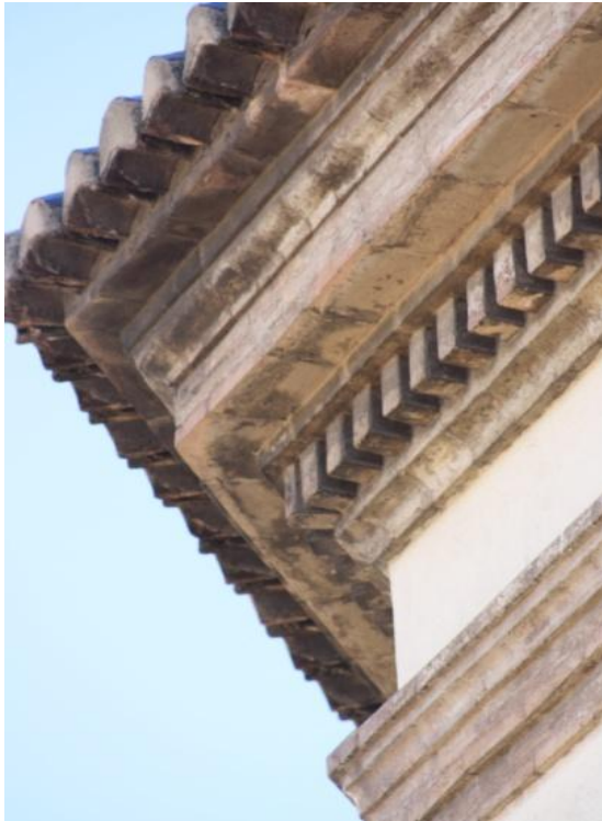
30. Detalle ladrillo aplantillado cornisa cúpula
