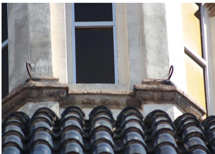
34. Detalle enganches tirantes linterna
