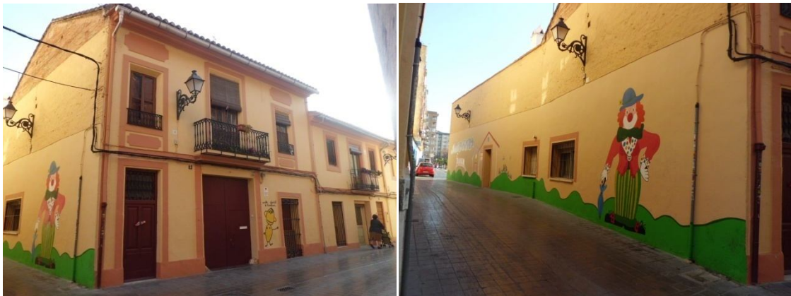
Calle Barón de Barcheta (fachada principal) Calle Dragaminas
