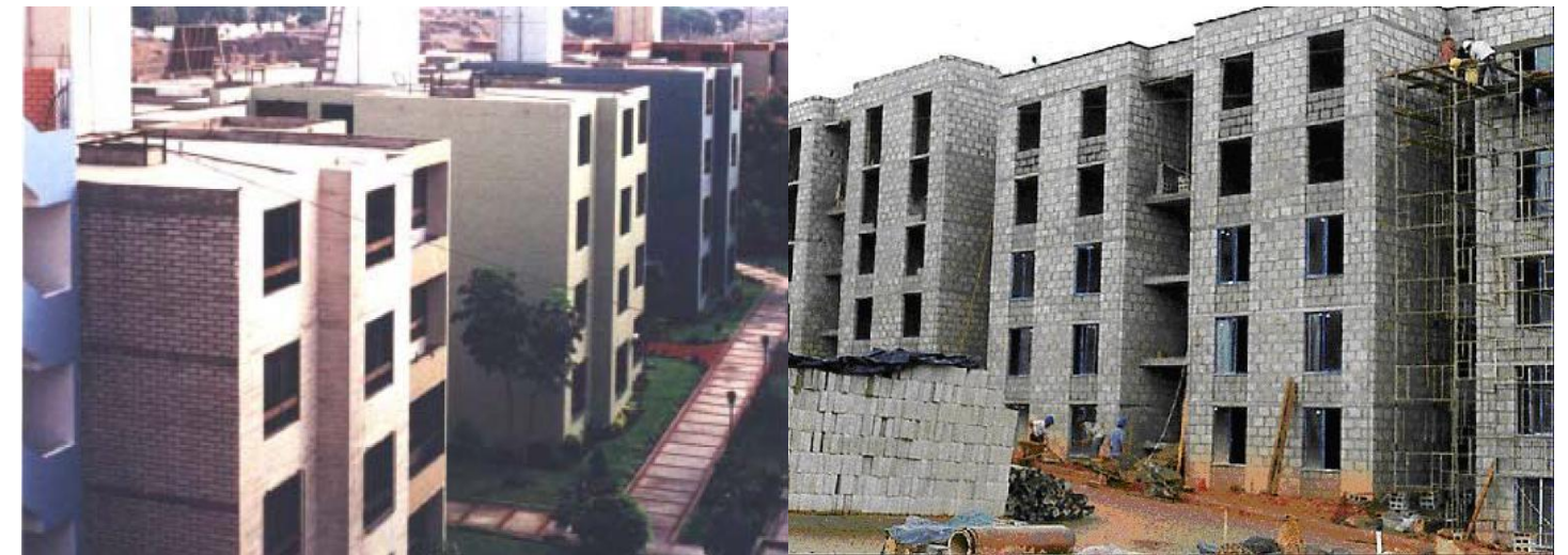
Izquierda, edificio de viviendas construido con muros de carga bloque silicocalcáreos, Perú. (A. San Bartolomé 1994) Derecha, edificio de viviendas construido con muros de carga bloque prefabricado de hormigón, Chile.
