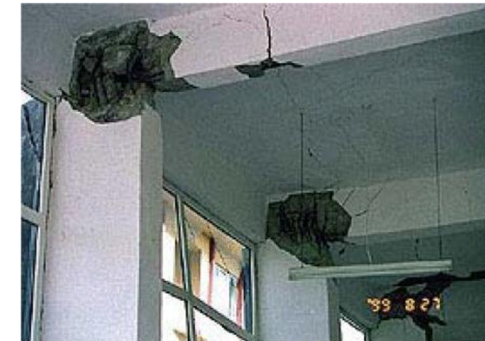
A la izquierda, diagrama que muestra la falta de cercos en la zona de rotura del pilar. A la derecha, Imagen del pilar de planta de estructura de hormigón armado tras el terremoto agosto de 1999, en Elazig, Turquía. ; Magnitud Richter 6.
