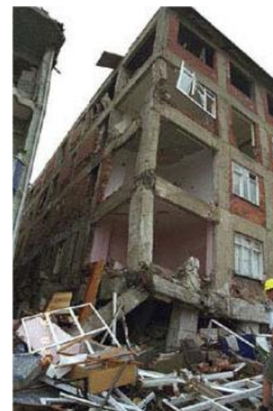
Imagen edificio de estructura de hormigón armado tras el terremoto agosto de 1999, en Elazig, Turquía. ; Magnitud Richter 6.
