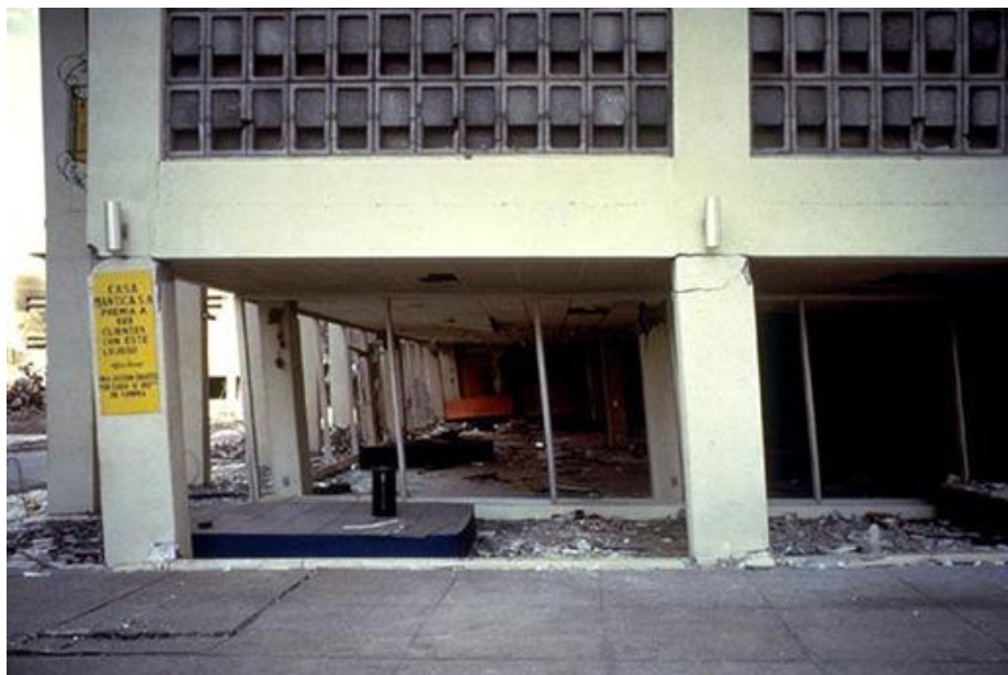
Edificio de estructura de hormigón armado y uso comercial, dañado durante el terremoto de Managua, Nicaragua de 1972.
