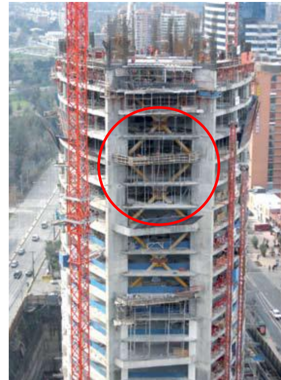
Imagen de la construcción de la Torre Titanium y detalle de uno de los disipadores de energía instalados.
