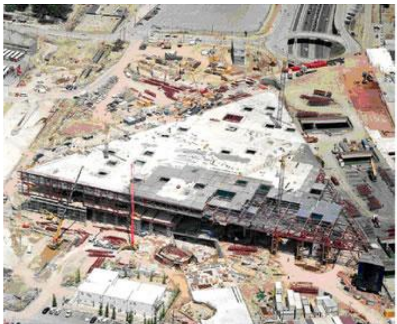
Imágenes de la construcción del edificio FORUM (2004) en Barcelona ( http://apta.com )
