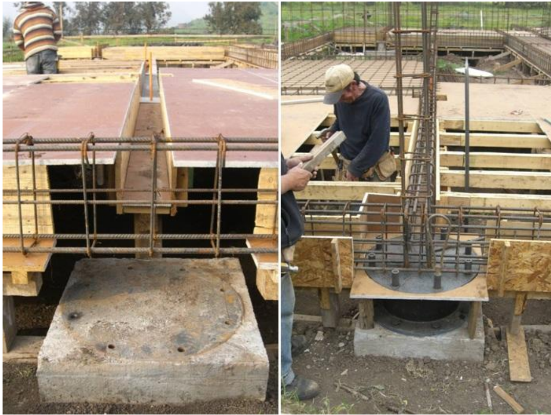
Base y colocación de uno de los aisladores sísmicos
