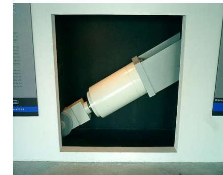
Imagen de la torre terminada y detalle de uno de los disipadores de fluido viscoso instalados construidos por la empresa Taylor Device, Inc.
