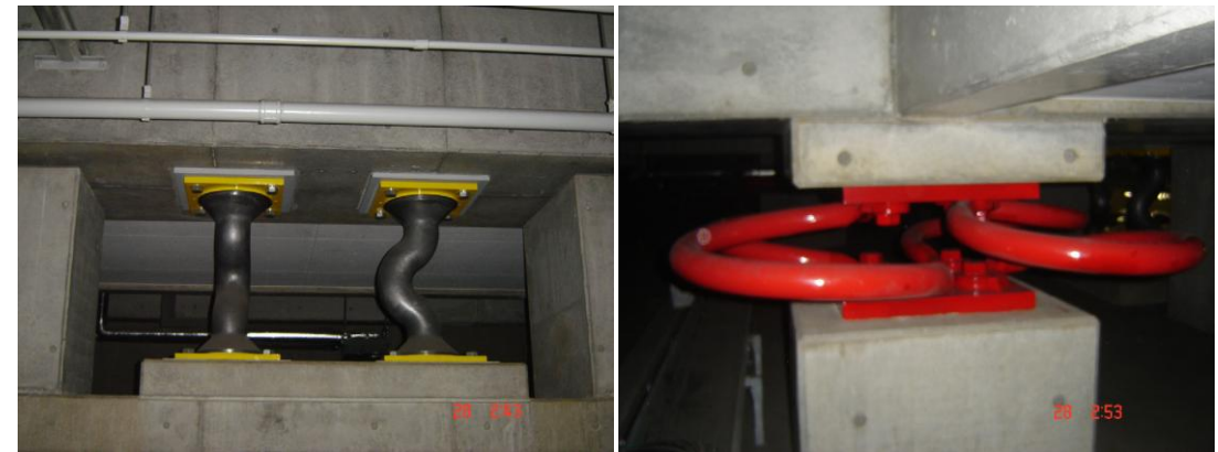
Distintos tipos de amortiguadores metálicos
