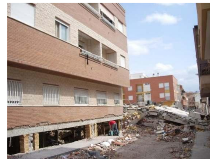
Las imágenes siguientes muestran ejemplos de los daños en pilares cortos en un edificio de construcción reciente apoyado en múltiples pilares cortos en Lorca, España, tras el terremoto de mayo de 2011.
