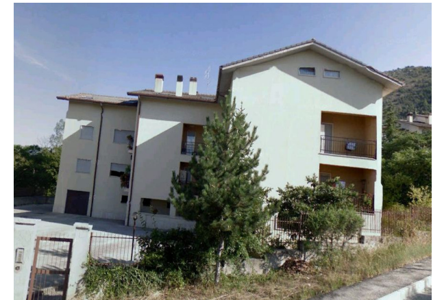
ESTADO ANTES DEL TERREMOTO
