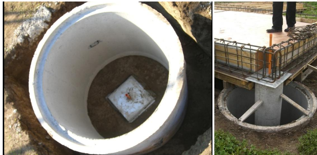
Base y colocación de uno de los aisladores sísmicos
