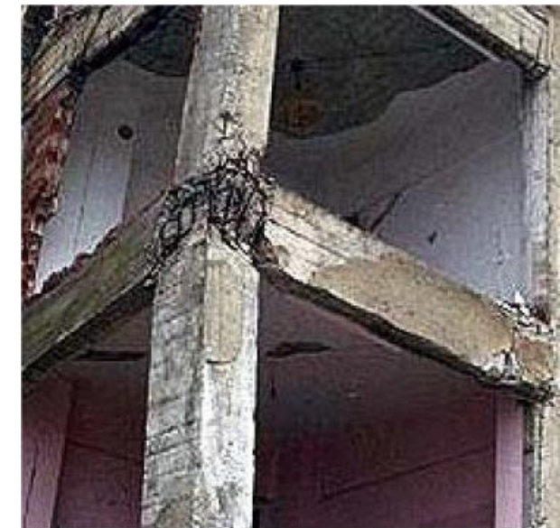
Imagen edificio de estructura de hormigón armado tras el terremoto agosto de 1999, en Elazig, Turquía. ; Magnitud Richter 6.
