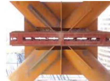
Imagen de la construcción de la Torre Titanium y detalle de uno de los disipadores de energía instalados.
