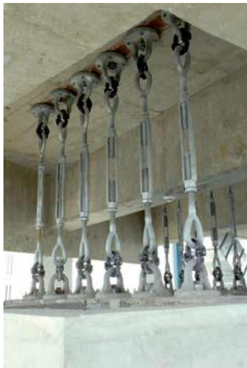
Imagen de los Amortiguadores de masa instalados en el edificio Parque Araucano, (Chile). Dos amortiguadores de masa sintonizada, cuelgan de la estructura mediante tensores, cuyos períodos de oscilación se ajustan y controlan dos tipos de movimientos: el de traslación y el de rotación respecto de un eje vertical. En el primero las dos funcionan sincrónicamente, y en el segundo actúan de forma opuesta, neutralizándose para reducir esta rotación. (Imagen)
