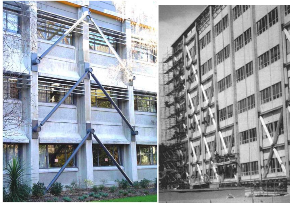
Izquierda, vistas de un pórtico arriostrado utilizado para la rehabilitación de una estructura existente de hormigón armado. (F. Crisafulli. Instituto latinoamericano del hierro y el acero) Derecha. Hospital México en San José de Costa Rica)
