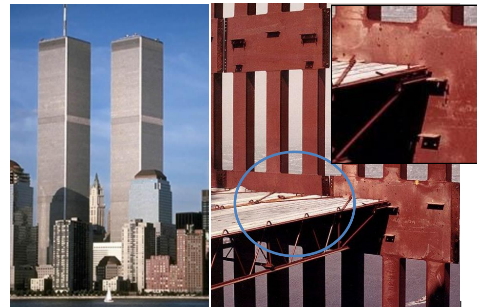
Izquierda. Imagen de las Torres Gemelas de Nueva York. Derecha. Detalle instalación de uno de los disipadores viscoelásticos.
