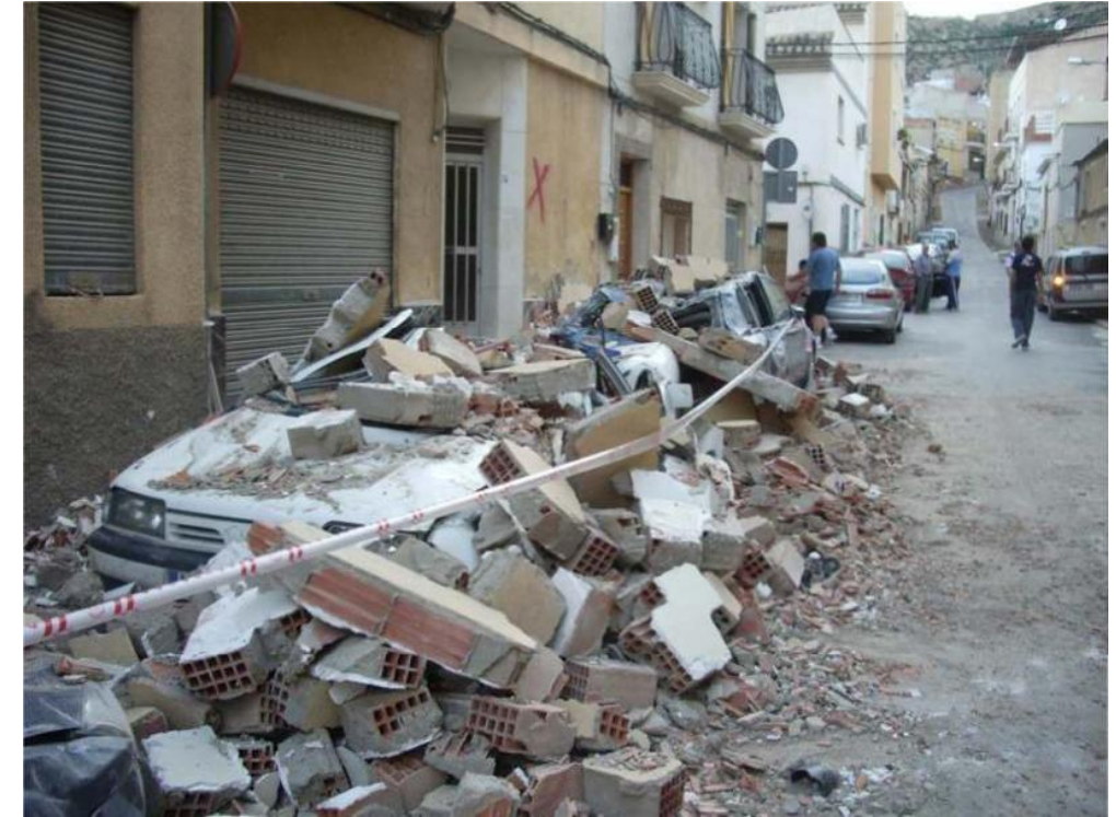
Caída de ladrillos procedente de una cornisa de un edificio cercano, tras el terremoto de Lorca, España, mayo de 2011.
