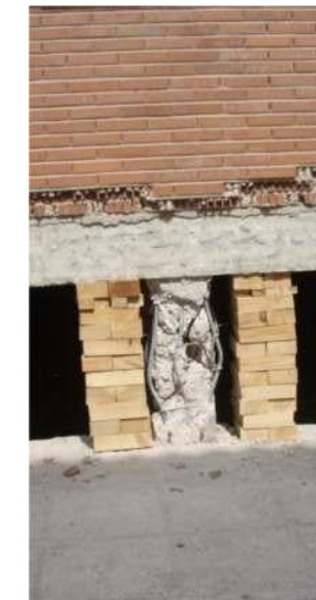
Las imágenes siguientes muestran ejemplos de los daños en pilares cortos en un edificio de construcción reciente apoyado en múltiples pilares cortos en Lorca, España, tras el terremoto de mayo de 2011.
