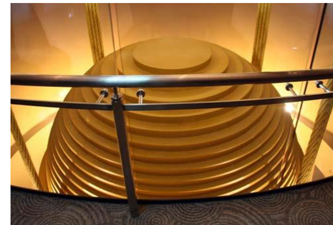
Arriba imagen del edificio Taipei 101 está situado en la ciudad de Taipéi, Taiwán. Abajo izquierda imagen del amortiguador de masa sintonizada. A la derecha, esquema de la situación del amortiguador en el edificio.
