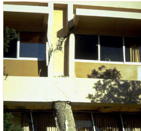
A la izquierda, diagrama que muestra la falta de cercos en la zona de rotura del pilar. A la derecha, Imagen del pilar de planta primera del Hospital de San Fernando, California. Edificio de estructura de hormigón armado con cerramiento y particiones interiores de fábrica de ladrillo dañado durante el terremoto Febrero de 1971; magnitud Richter 6,6; máxima intensidad M.S.K. VIII - IX
