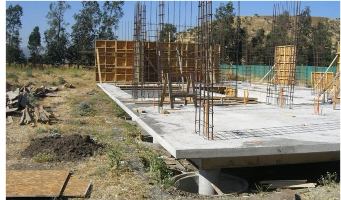
Forjado apoyado sobre el sistema de aislamiento.
