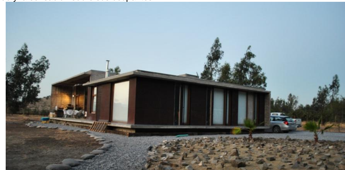
Imagen de la vivienda terminada.
