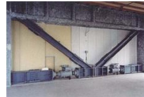
Izquierda, esquema de instalación del amortiguador de fluido en pórtico. Derecha, imagen real instalación del amortiguador. (Kobori Research Complex)
