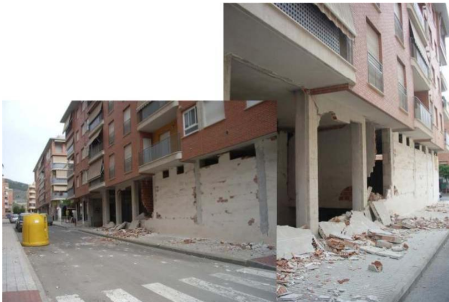
Imágenes que muestran ejemplos de los daños plantas blandas en un edificio de estructura de hormigón armado en Lorca, España, tras el terremoto de mayo de 2011.
