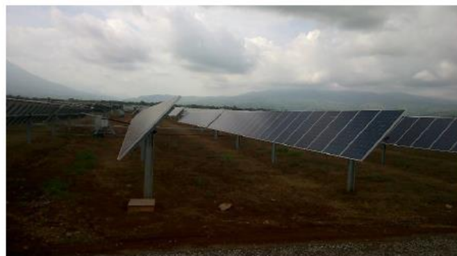
Figura 10 - "Imágenes seguidor solar en distintas posiciones del día" (Fuente: Tébar Martínez, E. [9] )
