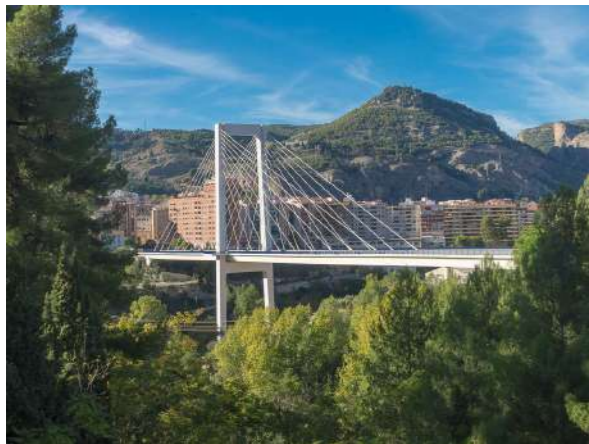
4 - PUENTE FERNANDO REIG
