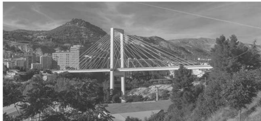
Puente Fernando Reig
