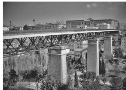
Puente del viaducto
