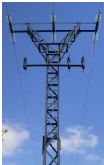
Figura 32: Apoyo de celosía (Fuente: fammsa.com)
