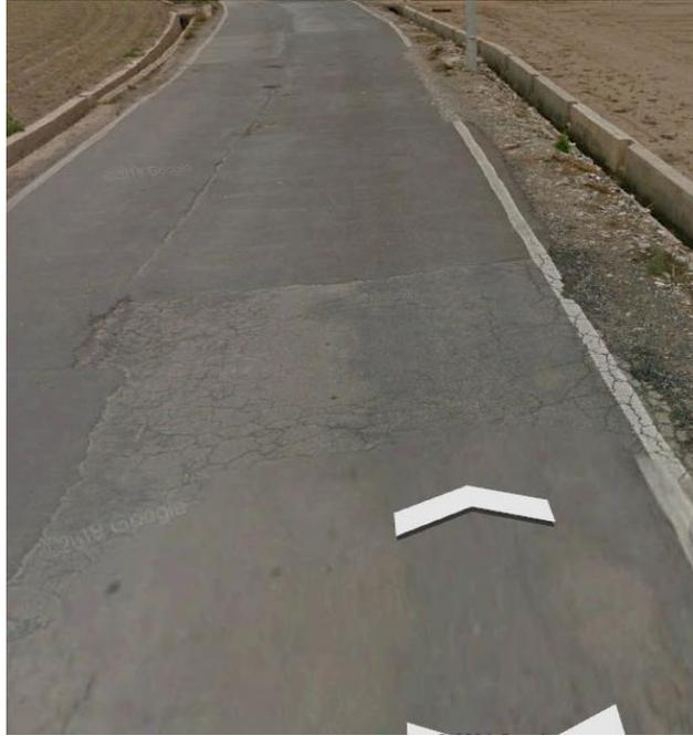
FIGURA 44: EJEMPLO DE AGRIETAMIENTOS ENCONTRADOS EN EL CAMÍ DE FARINÓS
