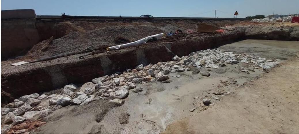
FIGURA 84: AMPLIACIÓN DE LA V-21, EN LAS QUE SE PUEDE OBSERVAR LAS DISTINTAS MEJORAS DE TERRENO
