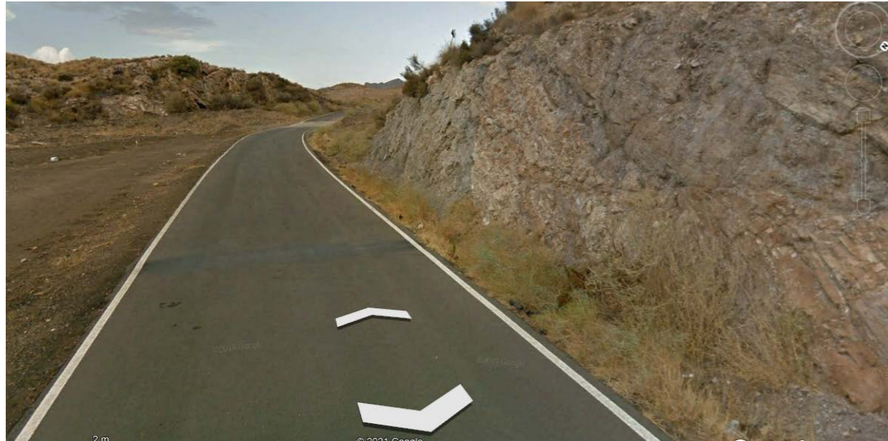
Figura 6. Talud vertical de desmonte en las rocas terciarias en la zona. (Fuente: Google Maps).
