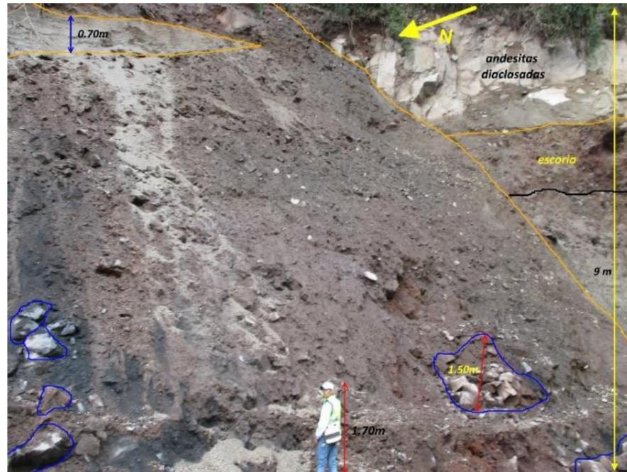
Figura 35. Antigo deslizamiento, margen derecha del portal de entrada (757831E; 9950034N).
