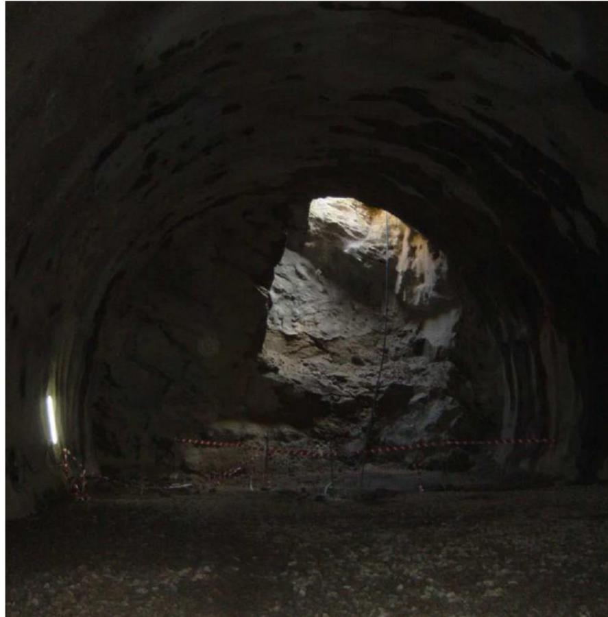
Figura 54. Ejemplo de chimenea en un túnel. Fuente: Leopoldo Jordá Guijarro.
