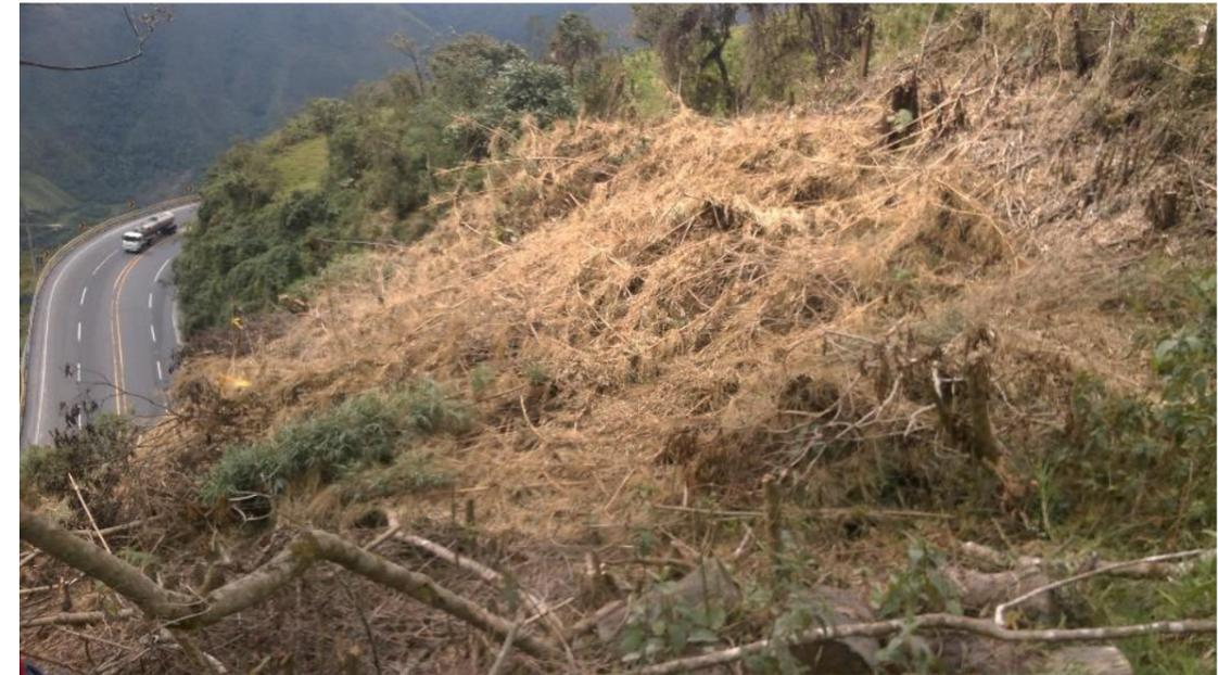
Figura 37. Deslizamiento rotacional suspenso. Portal de salida (759191E; 9950975N).
