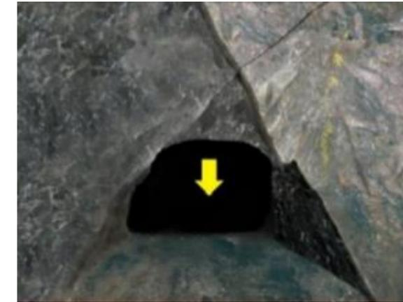
Figura 49. Formación de cuñas bipolares durante la excavación del túnel (Tolentino, 2014).
