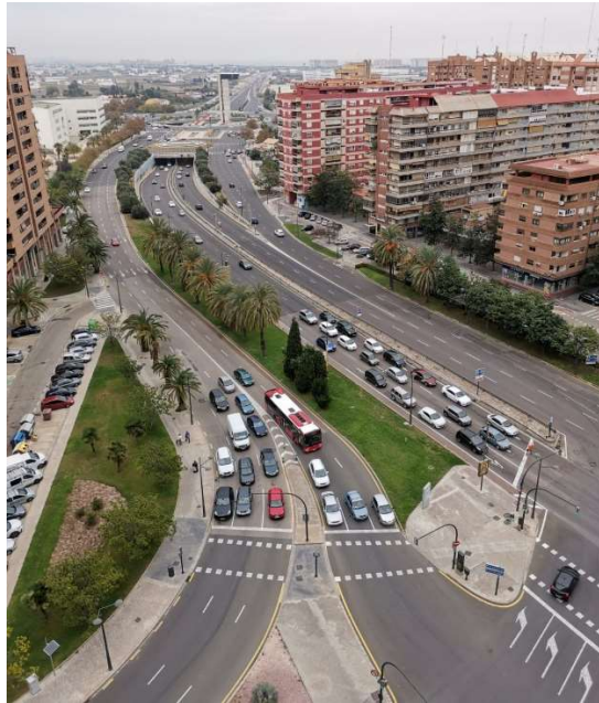
Ilustración 4. Acceso a la ciudad de Valencia por el norte, V-21, y Av. Cataluña. Fuente: Propia.
