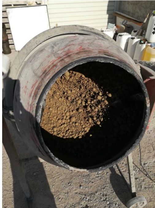
Figura 4.14. Mezcla de materiales en la hormigonera. Fuente: Elaboración propia
