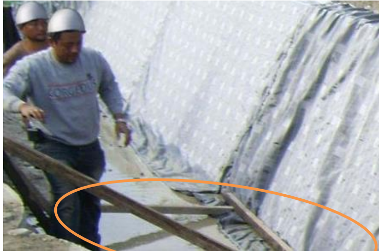
Figura 8.15. Ejemplo de anclaje del colchón geotextil
