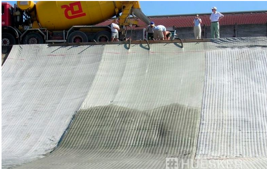
Figura 8.21. Ejemplo de relleno simultáneo de diferentes colchones
