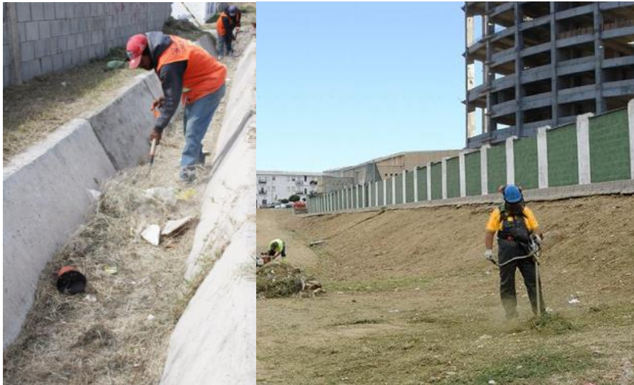
Figura 8.2. Ejemplo de desbroce de canal mediante medios manuales. Fuente: Hzach Chile
