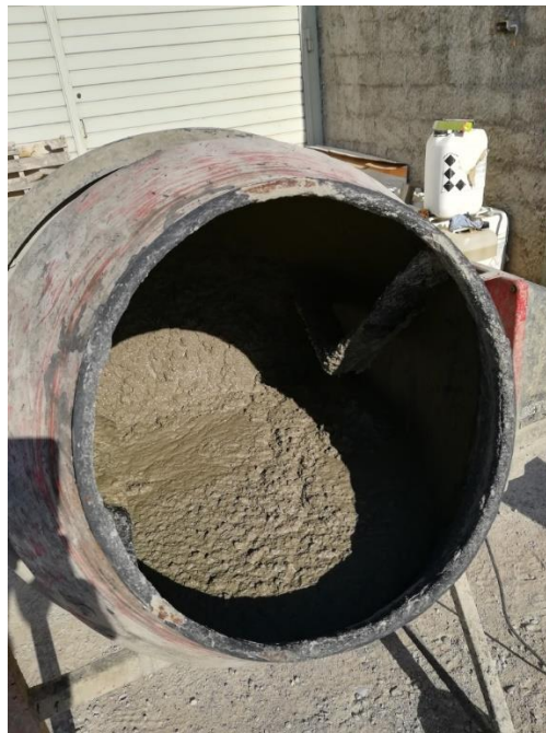
Figura 4.16. Mezcla de hormigón finalizada. Fuente: Elaboración propia
