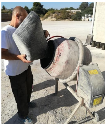
Figura 4.15. Vertido de insumos en la hormigonera. Fuente: Elaboración propia
