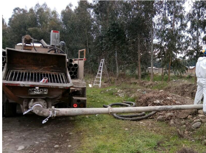
Figura 8.6. Camión bomba empleado y conducto de bombeo
