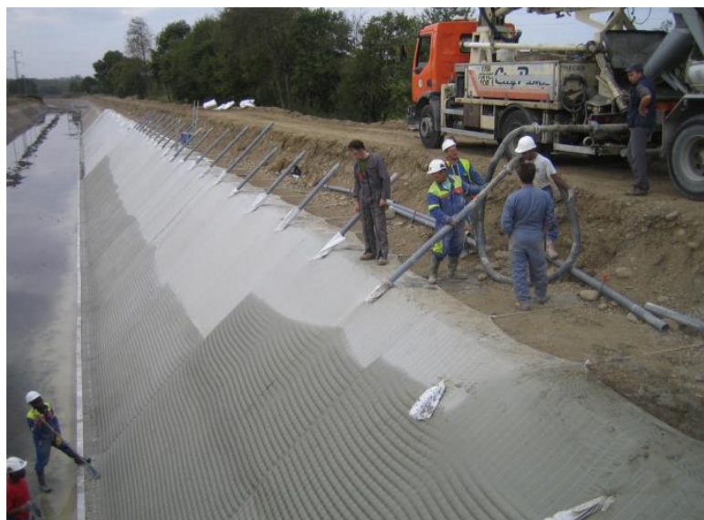
Figura 8.20. Ejemplo de relleno simultáneo de diferentes colchones
