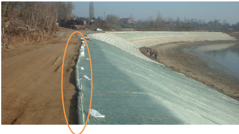
Figura 8.16. Ejemplo de anclaje del colchón geotextil
