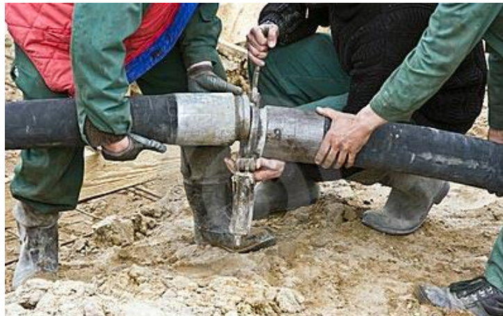
Figura 5.1. Sellado de juntas en manguera para bombeo de hormigón
