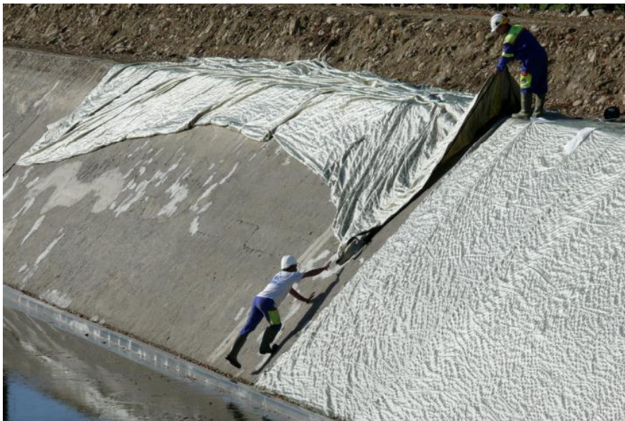
Figura 8.14. Ejemplo de extendido del colchón geotextil
