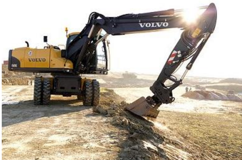
Figura 8.4. Ejemplo de perfilado de canal mediante medios mecánicos. Fase final.
