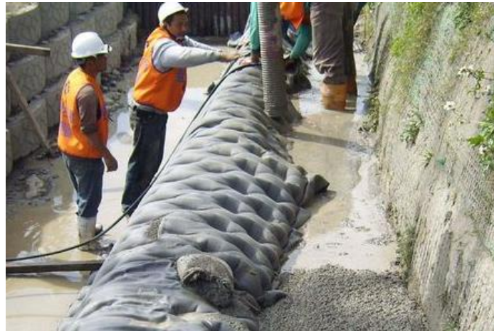
Figura 8.25. Ejemplo de anclaje definitivo del colchón
