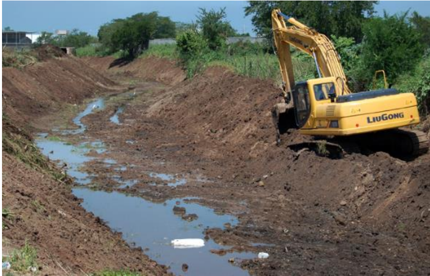
Figura 8.3. Ejemplo de perfilado de canal mediante medios mecánicos. Fase inicial.
