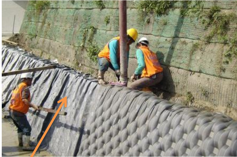
Figura 8.19. Ejemplo de inserción de la manguera en el colchón geotextil
