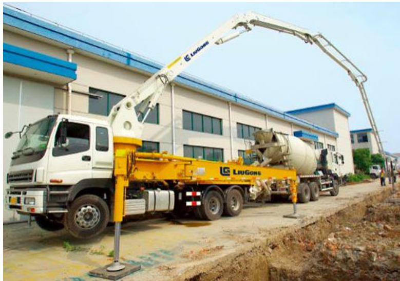
Figura 5.2. Estabilizadores de camión bomba de hormigón
