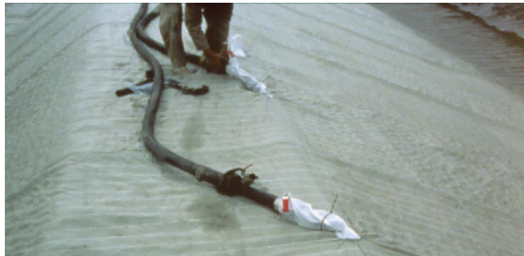
Figura 8.18. Ejemplo de inserción de la manguera en el colchón geotextil
