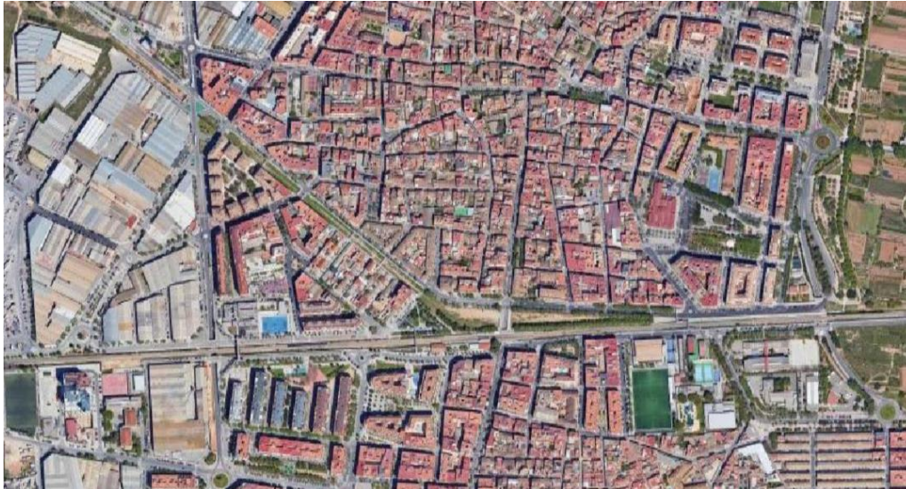
Ilustración 6. Vías del ferrocarril y Barranco de La Saleta dividiendo el casco urbano. Fuente: Google Maps.
