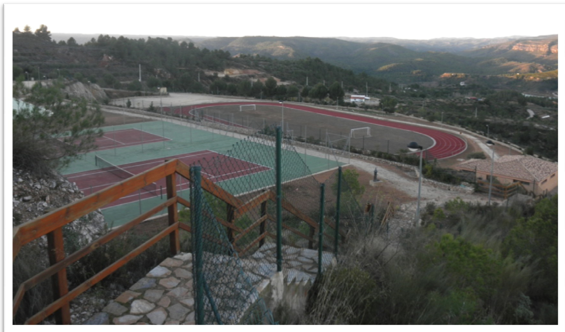
Imagen 3.4. Escalera de comunicación entre terrazas.
