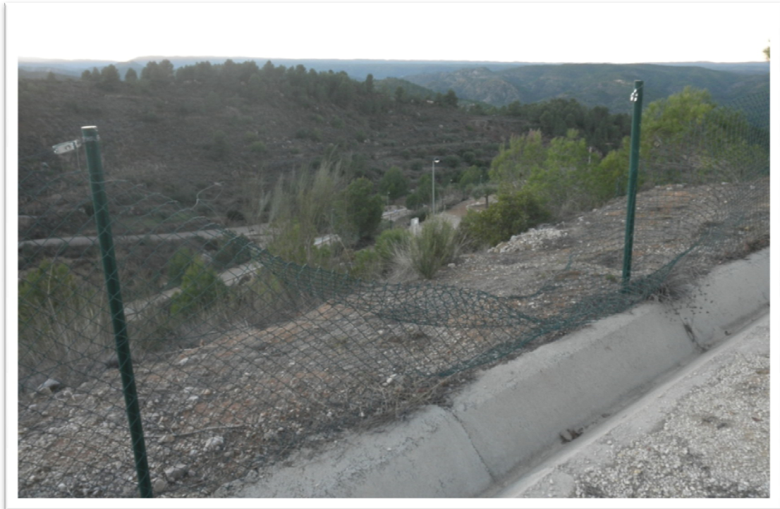
Imagen 3.11. Enrejado delimitador de las instalaciones.
