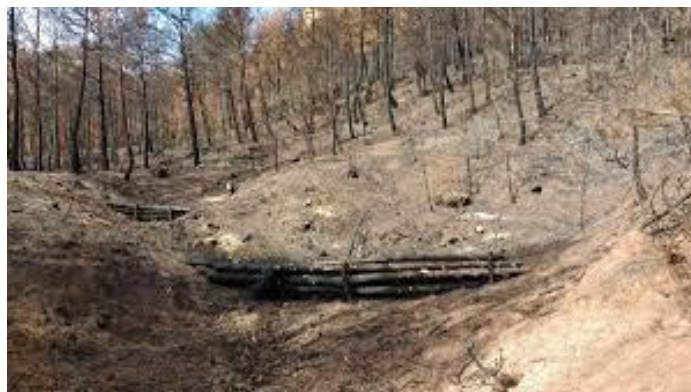
Figura 3. Albarradas elaboradas con fustes de pies quemados. Fuente: Guillén (2017).
