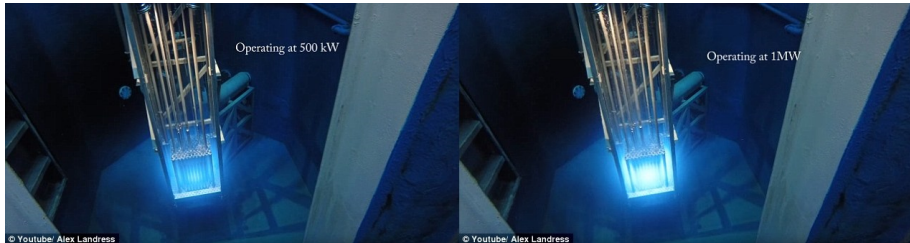
Figura 13: Radiación de Cherenkov generada por el reactor nuclear Breazeale Nuclear Reactor en el agua que actúa como sistema de refrigeración. La fantasmagórica luz azul es más intensa cuando el reactor pasa de operar a 500 kW a 1 MW pues aumenta la emisión de partículas cargadas
