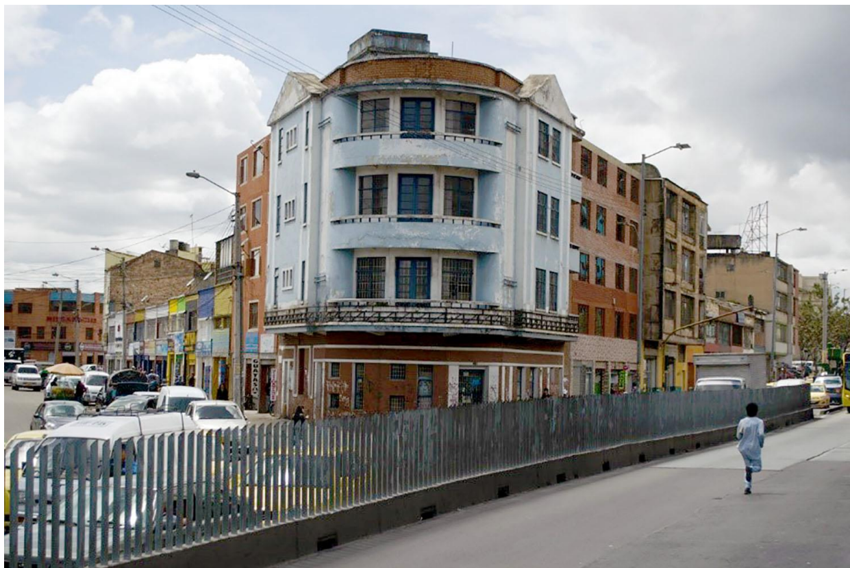
Fig. 3.2-6 Edificio abandonado sobre la Avenida Caracas construido durante la primera parte del siglo XX bajo la influencia del estilo “moderno” (Vásquez, 2016).
