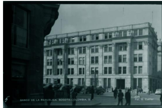
Fig. 1.4-30 Banco López del arquitecto estadounidense Robert Farrington (1919-1924), primera construcción en acero y hormigón del país (Cuéllar Jiménez, 1930b).
