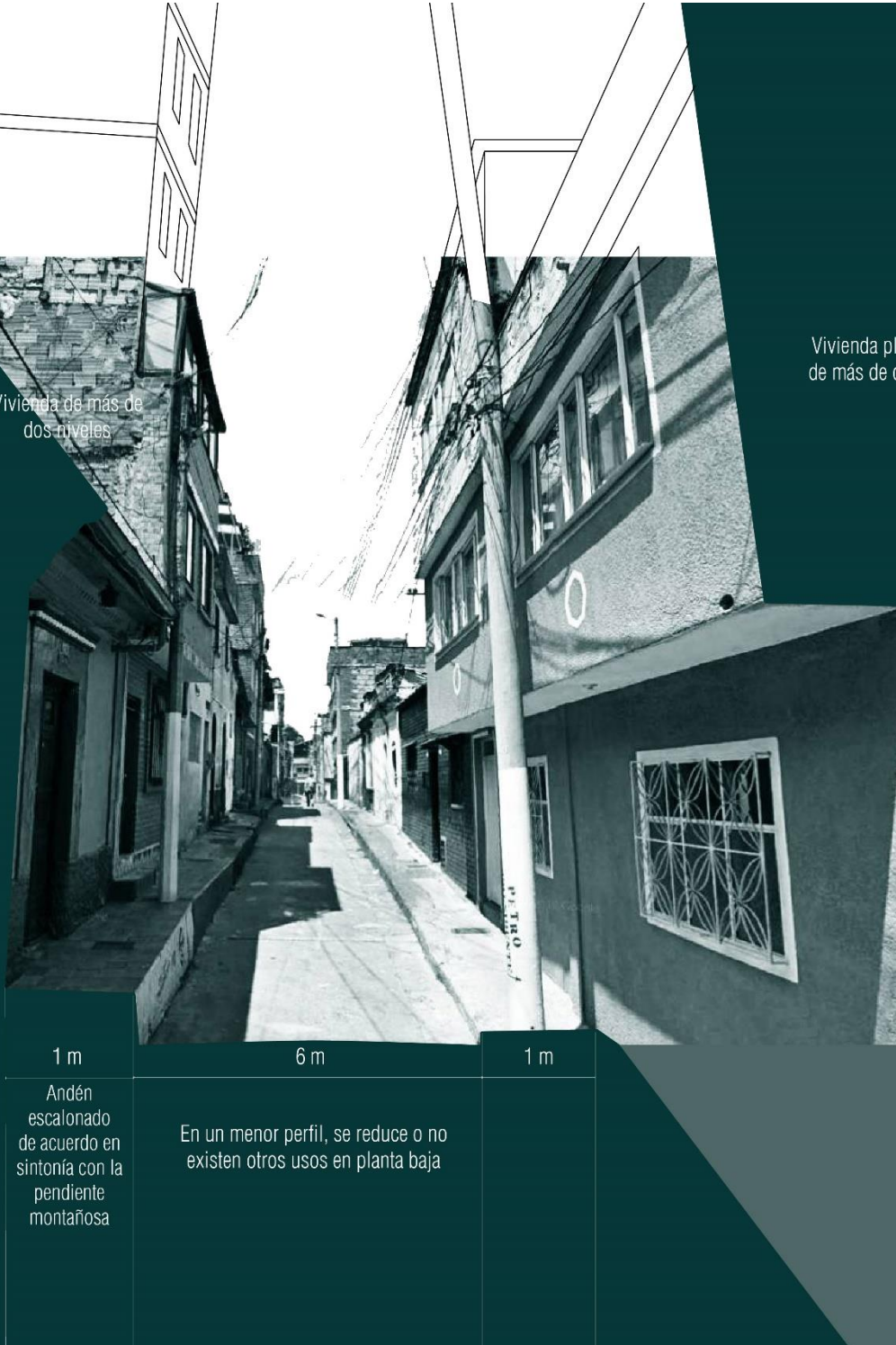
Fig. 2.2-18 Perfil vial de 6 metros en el barrio La Perseverancia en la localidad de Santa Fe. Elaboración propia a partir de imagen tomada de (Google, 2021).
