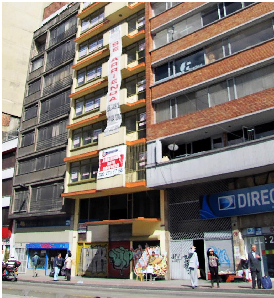
FIG. 3.2-18 Edificio sin uso y en arriendo sobre la Avenida Fernando Mazuera (Díaz Cruz, 2015).
