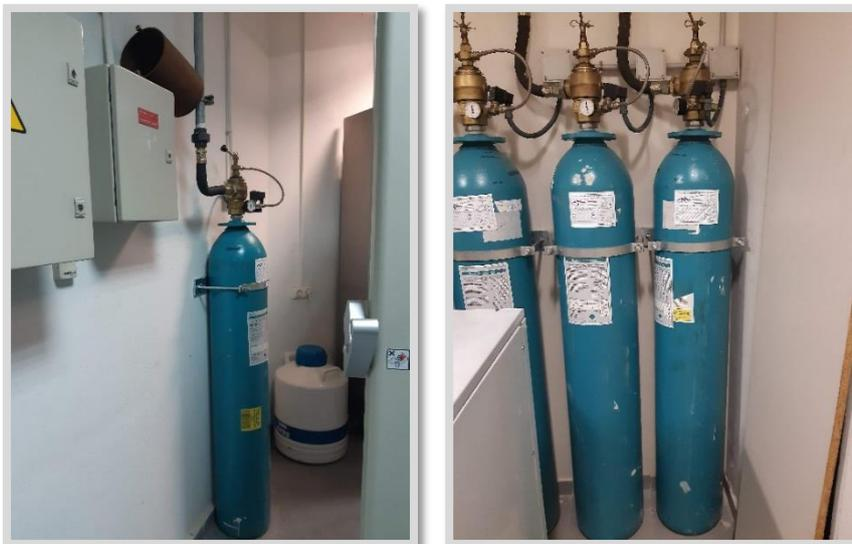
Figura 16 Central de detección y botellas de extinción.
