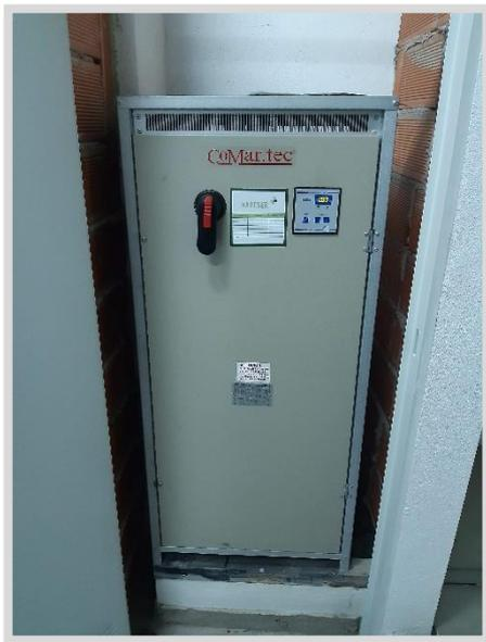
*Figura 5 Batería de Condensadores*
