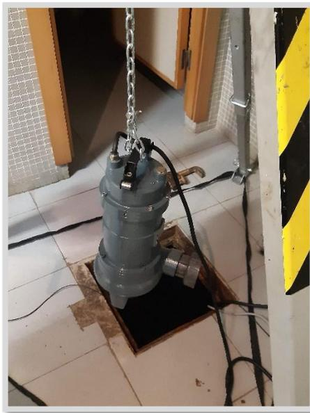
*Figura 9 Bomba Fecal en el momento de su instalación*
