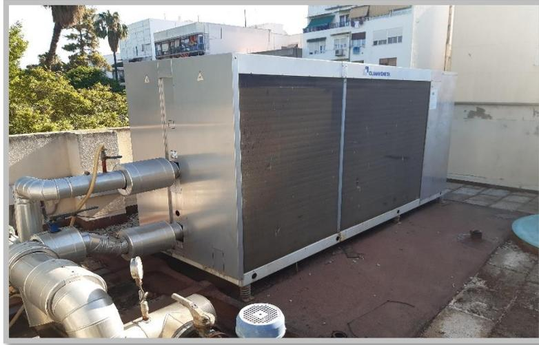
*Figura 10* Enfriadora del Edificio
