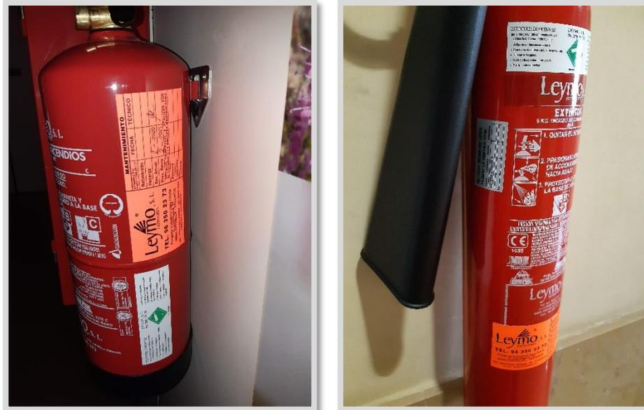
Figura 17 Extintores del Edificio: Extintor Clase ABC y Extintor Clase CO<sup>2</sup>
