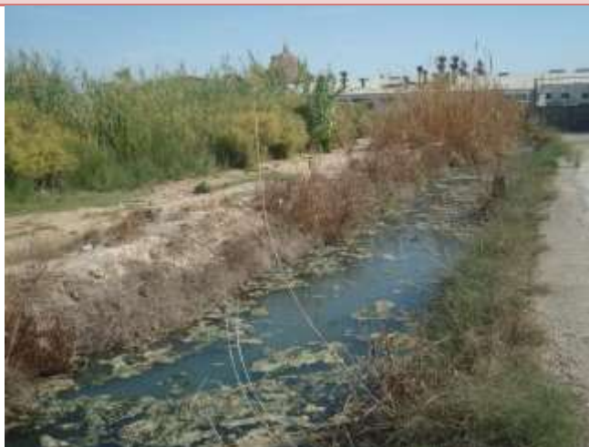
Figura 15. Contaminación de acequias. Fuente: Google imágenes
