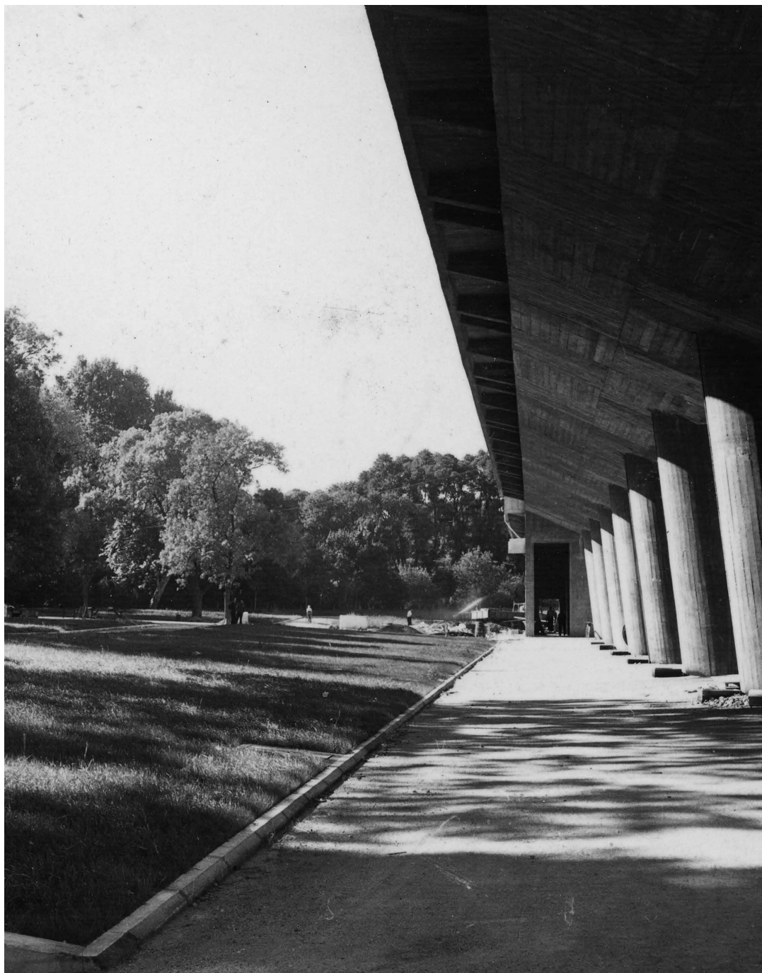
FIG. 5 Unité d'habitation de Marseille. Les pilotis. Photographie Lucien Hervé. FLC L2(2)68_330. FLC/ ADAGP/J.Paul Getty Trust_ Courtesy of Judith Hervé
