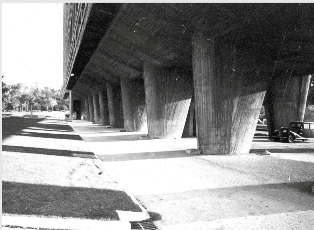
FIG. 2 Unité d'habitation de Marseille. Les pilotis. Photographie Lucien Hervé. FLC L2(2)79_157. FLC/ ADAGP/J.Paul Getty Trust_ Courtesy of Judith Hervé.
