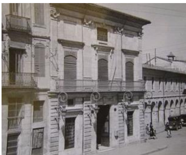
Ayuntamiento de Sueca y parte de la Casa Santamaría. Fotografía postal de 1959.
