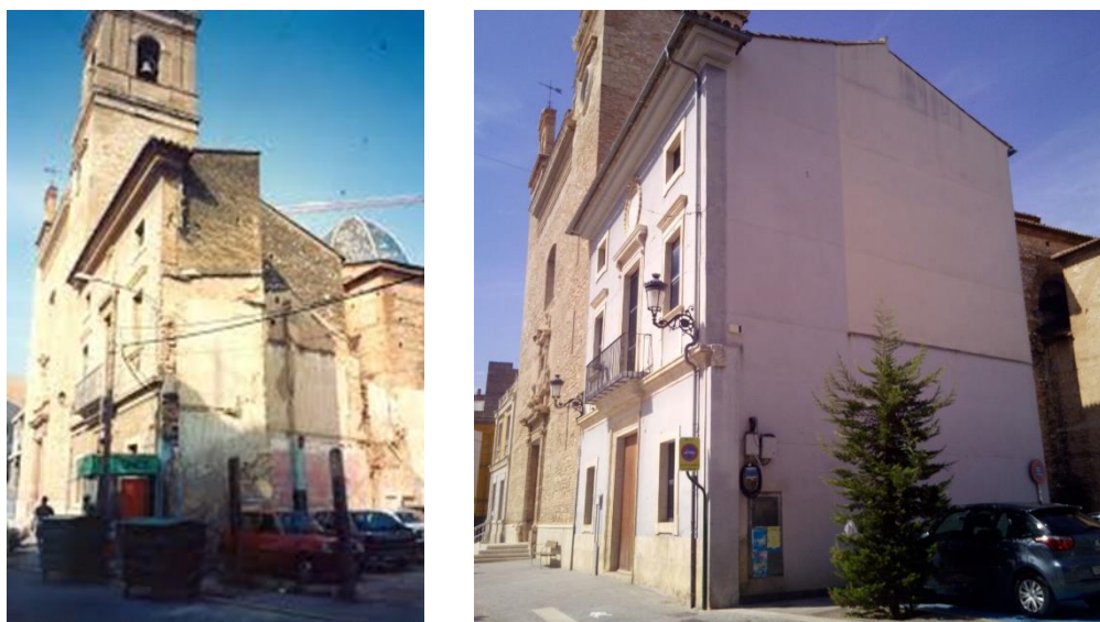
Volumen del Ayuntamiento de Silla en 1992 construido según el proyecto de Gascó (izquierda) y edificio actual (derecha) tras la rehabilitación integral de 2003.
