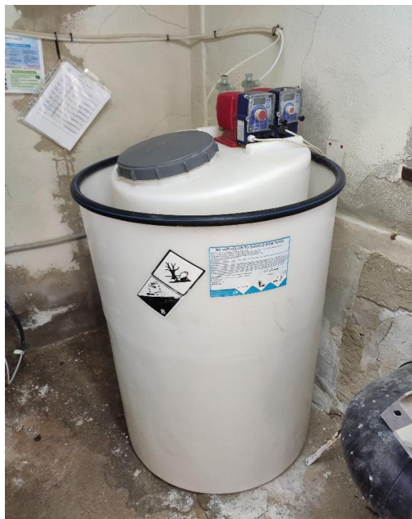
Figura 10. Sistema de dosificació de NaOCl
