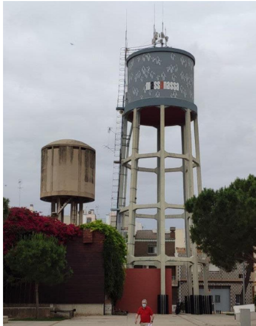
Figura 11. D'esquerra a dreta: antic dipòsit de compensació, actual dipòsit
