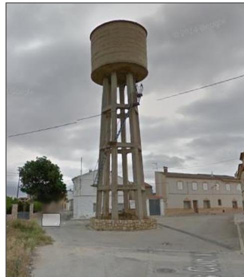
Imagen 14: Depósito Casas del Cerro
