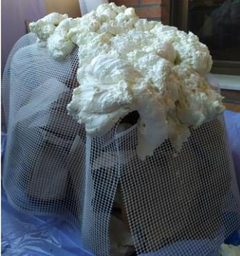
Figura 23. Primera aplicación de la espuma de poliuretano
