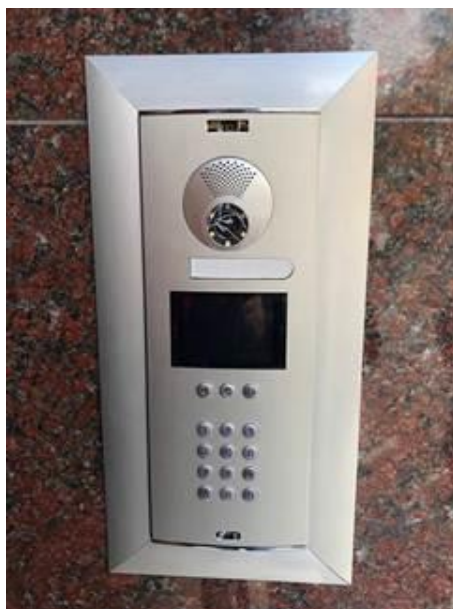
Figura 130. Placa sustitutiva de la instalación piloto 01
