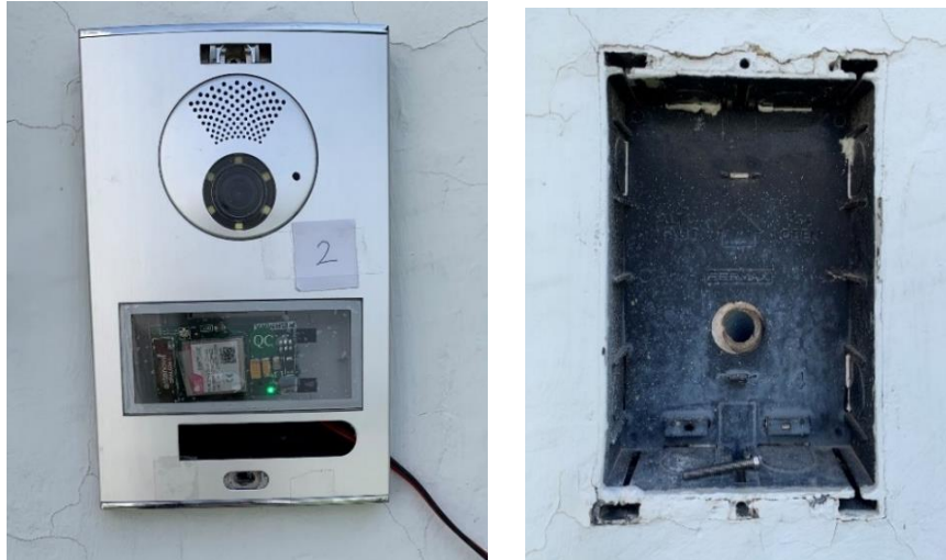
Figura 81. Placa con caja de empotar de plástico en la pared
