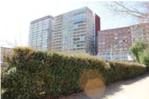
Vallado de las instalaciones deportivas.
