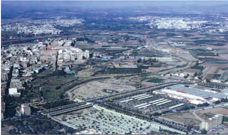
Vista aérea de la intervención en fase de ejecución. Muñoz, A, et al. Ayuntamiento de Valencia. 1998.
