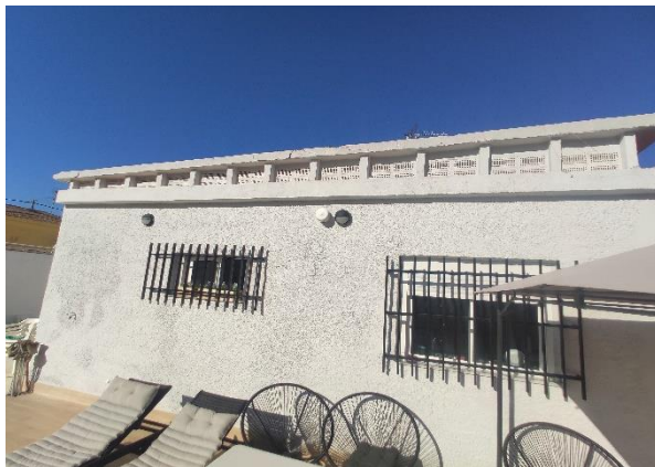
Imagen 1. Fachada oeste. Fuente: elaboración Propia
