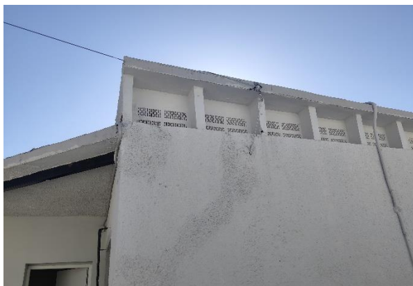
Imagen 2. Fachada este. Fuente: elaboración Propia
