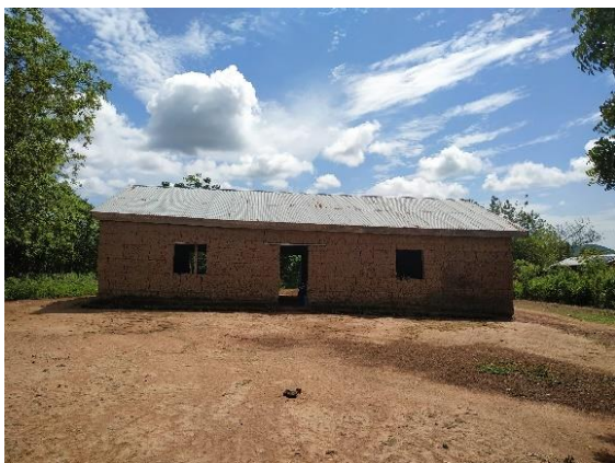
Figura 55: Nuevo taller. Fuente: Propia
