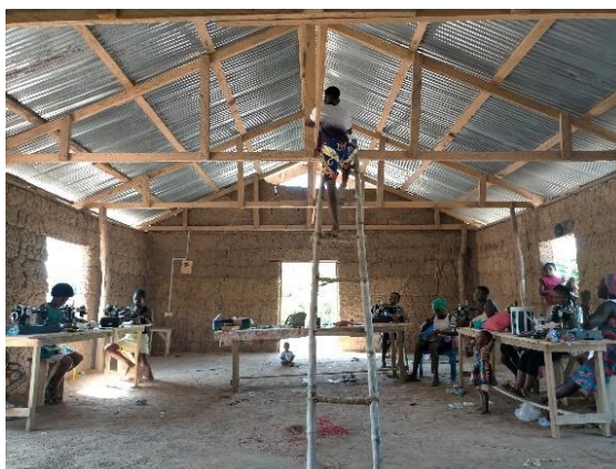
Figura 56: Trayendo la electricidad al nuevo taller. Fuente: Propia
