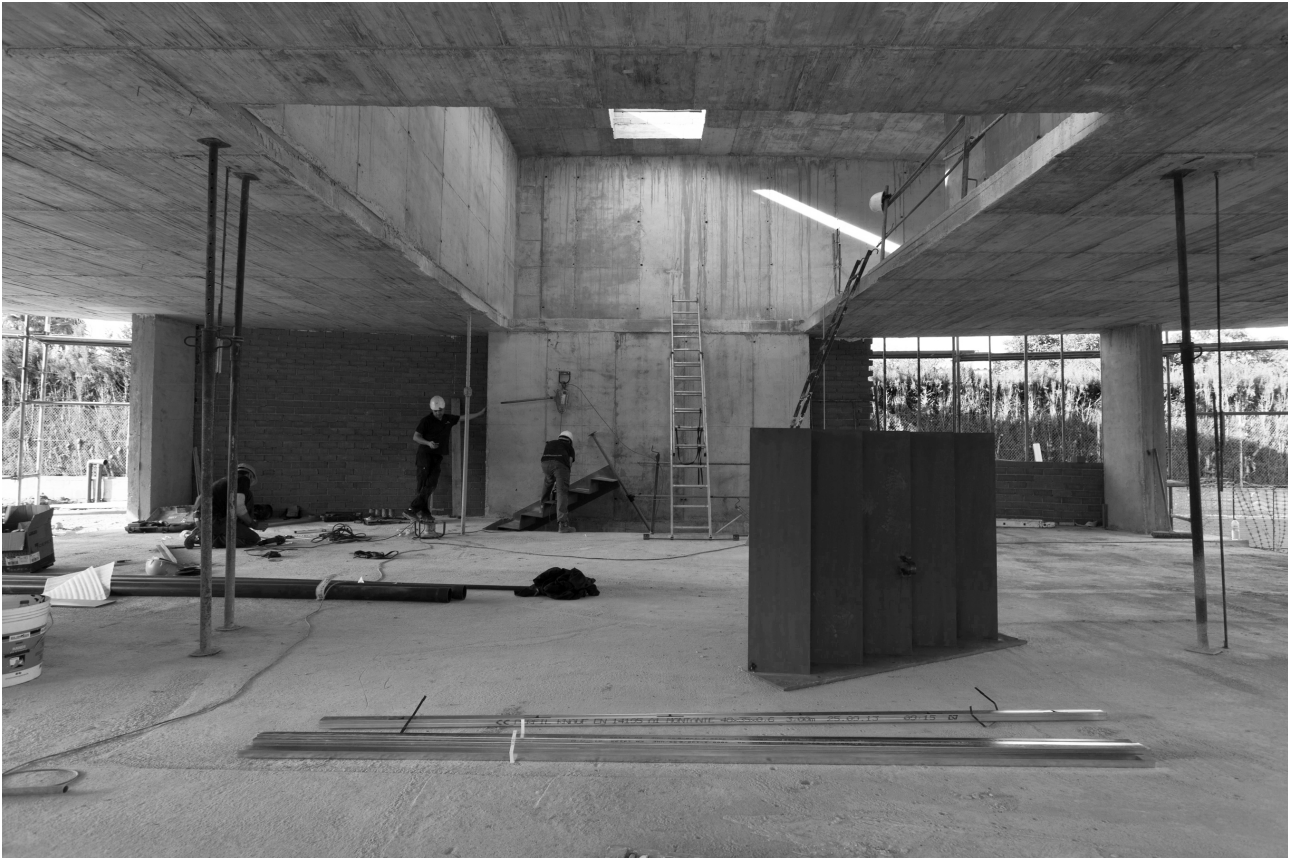
Figura 3.2.-5. Fotos obra Casa Balint. Doble altura interior. Fuente: Fran Silvestre Arquitectos
