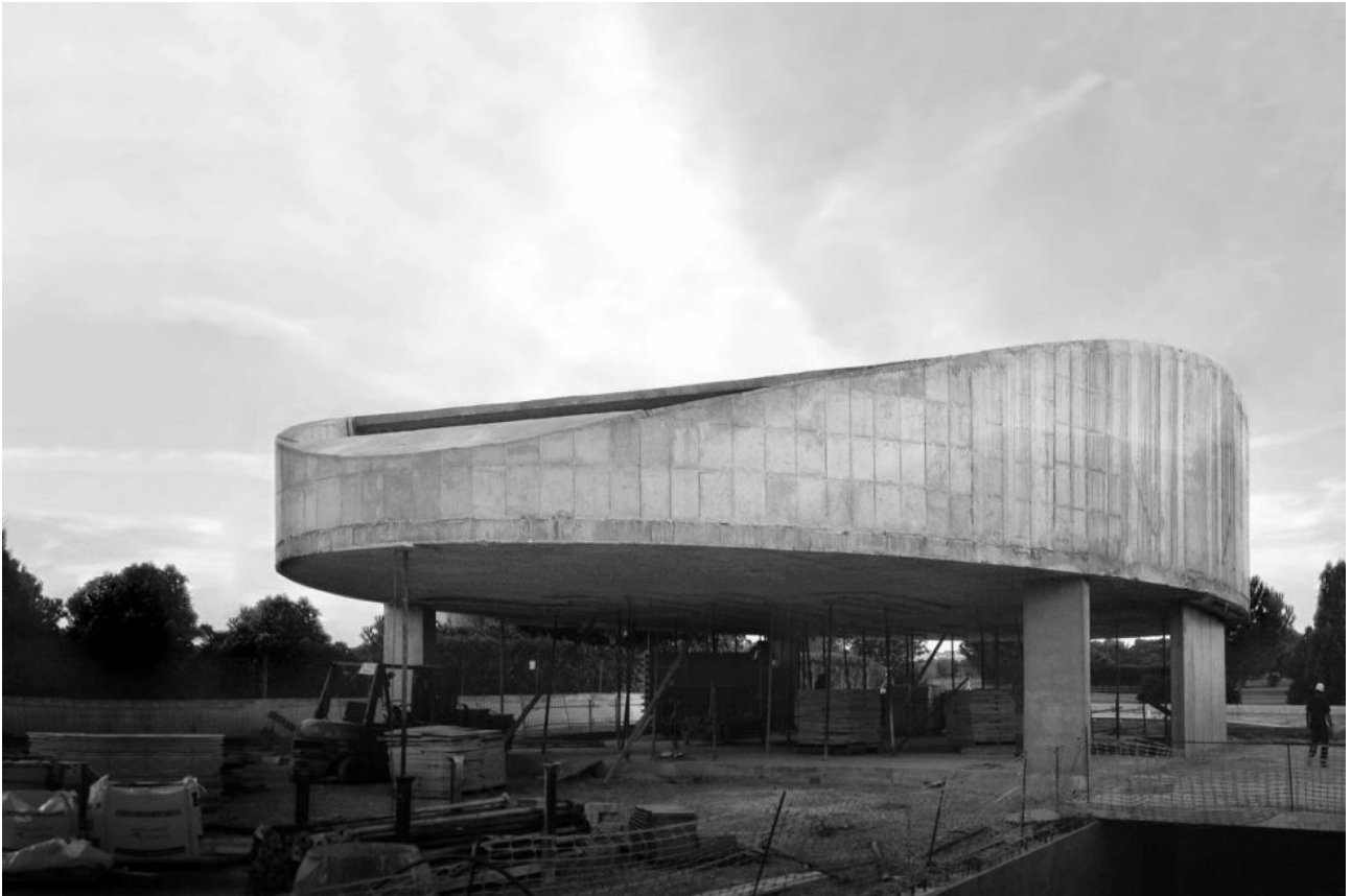
Figura 3.1.-7. Fotos obra Casa Balint. Anillo perimetral de canto variable. Fuente: Fran Silvestre Arquitectos
