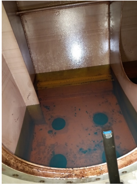
Figura 6: Tanque de combustible dotado de dos compartimentos de acero inoxidable con capacidad de 4500 litros en total.
