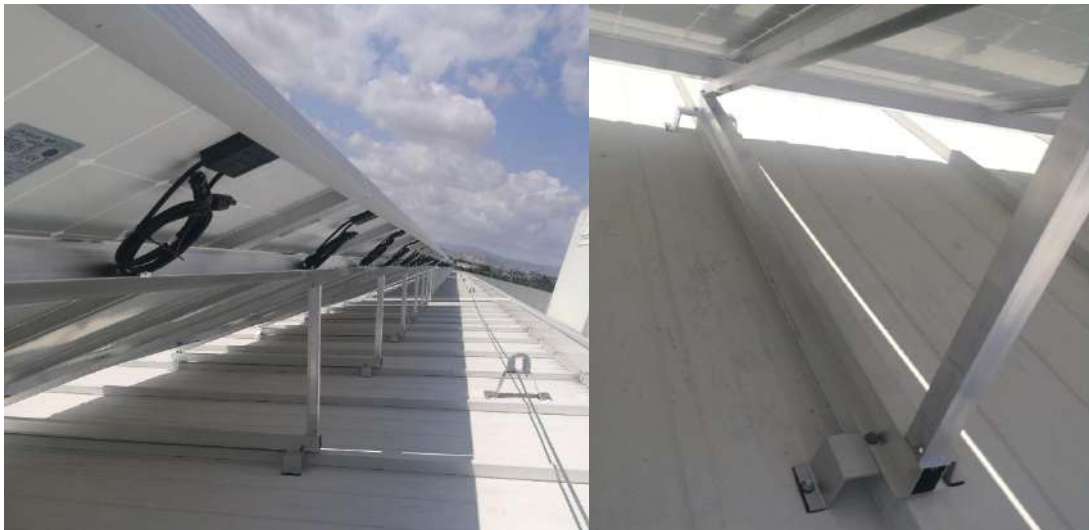
Ilustración 26: Estructura de aluminio montada sobre cubierta de chapa metálica.
