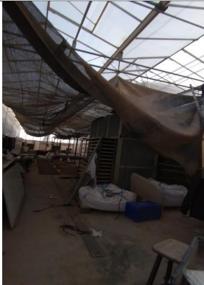
Figura 2: Renovación de la cubierta de la protección solar del invernadero N°19.
