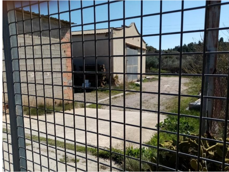
Ilustración 17: Imagen edificación existente (2)
