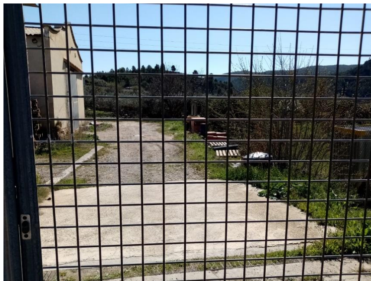
Ilustración 16: Imagen edificación existente (1)
