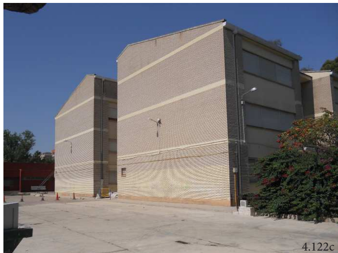
Figura 4.122. CEIP Vivers (Villar Palasí): fachada principal, fachada posterior y lateral izquierdo. Fuente: fotografías del autor.
