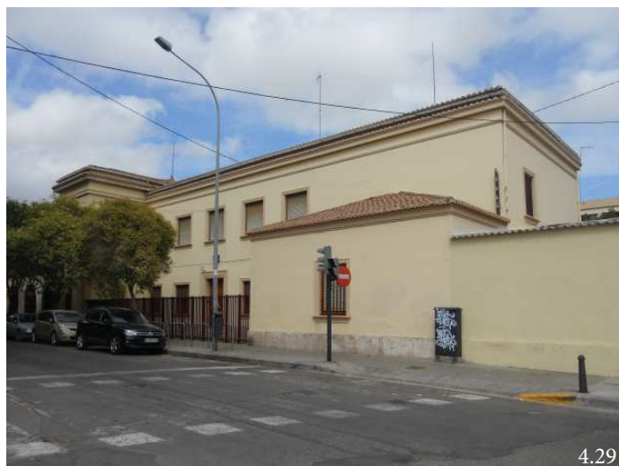
Figuras 4.27. a 4.29 CEIP Padre Manjón, Teodoro Llorente y Salvador Tuset. Fuente: fotografías del autor.
