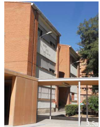
Figura 3.5. CEIP Doctor Barcia Goyanes. Entrada del edificio principal y aulas de infantil (ampliación). Fuente: fotografías del autor
