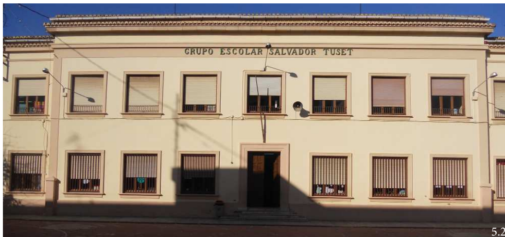
Figura 5.2. CEIP Salvador Tuset. Fuente: fotografía del autor.
