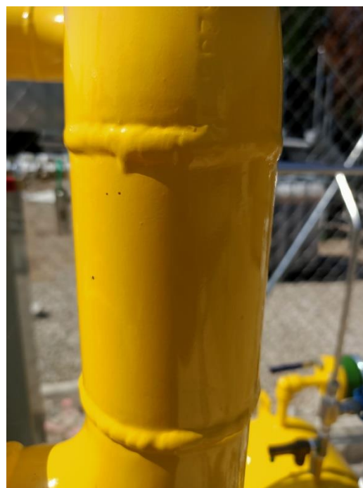
Ilustración 22 Foto soldadura ERM
