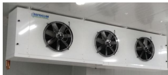
Ilustración 62. Evaporador.
