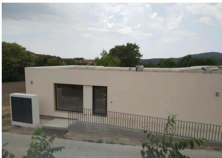
Fig. 7 Imagen del acceso. Fuente: Francisco Cubero (Encargado de obra de Metro7) 2021.
