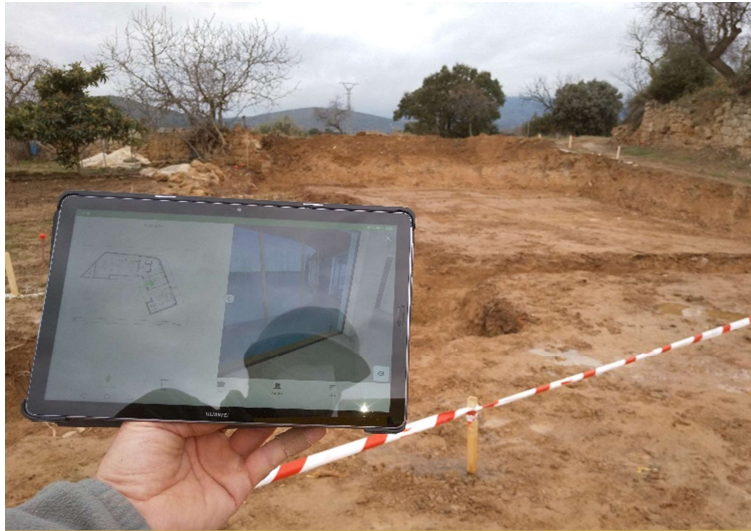
Fig. 5 Utilización de herramientas OpenBIM en obra. Fuente: Francisco Cubero (Encargado de obra de Metro7) 2021.
