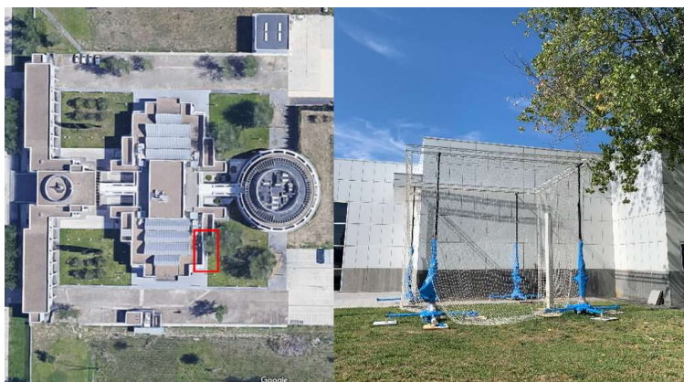
Fig. 2 Localización y vista de la fachada objeto de estudio donde se observa el espacio delimitado para realizar los vuelos del dron respetando las medidas de seguridad vigentes. Fuente: proyecto Robim (Ibim). 2020
