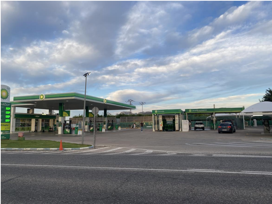
Figura1: Imagen panorámica de la estación BP de Pego
