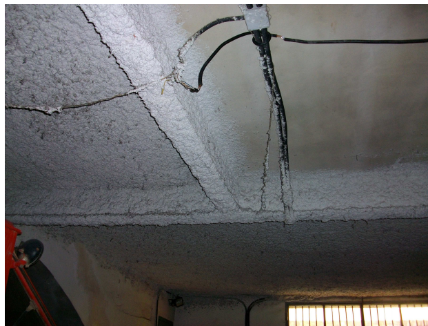
Forjado zona norte
