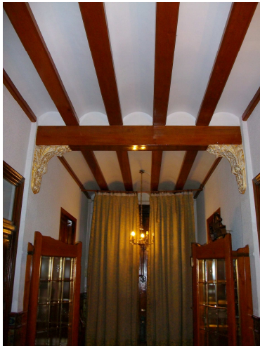
Forjado vivienda original
