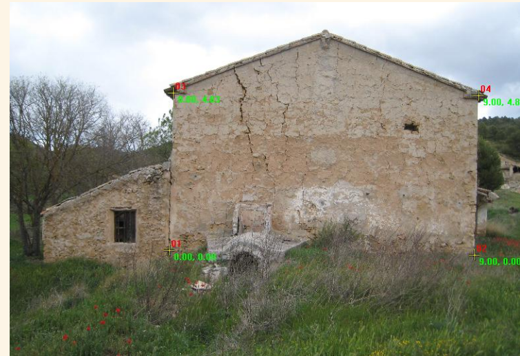
Fachada sur-oeste (ASRIX)
