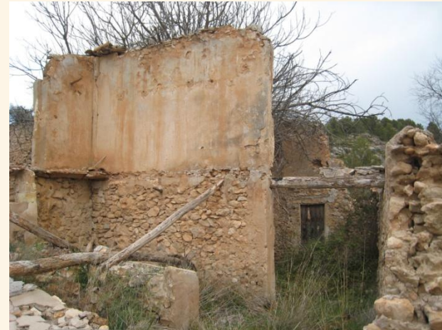
Muro de mampostería (Molino de los Batanes)
