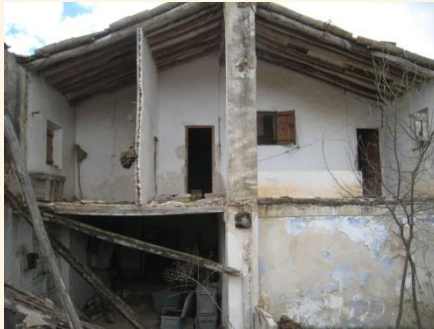
Viga central y pares inclinados (Molino de la Hoz)
