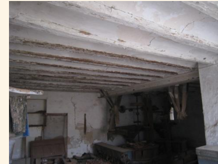
Forjado rehabilitado (Molino de Garrido)
