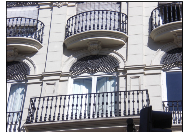
Hueco de fachada Piso 2
