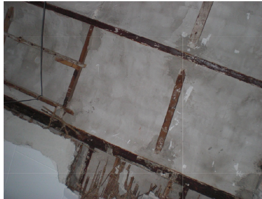
(Cara inferior del forjado Nivel 1.)
