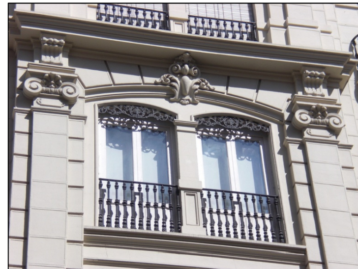
Hueco de fachada Piso 3
