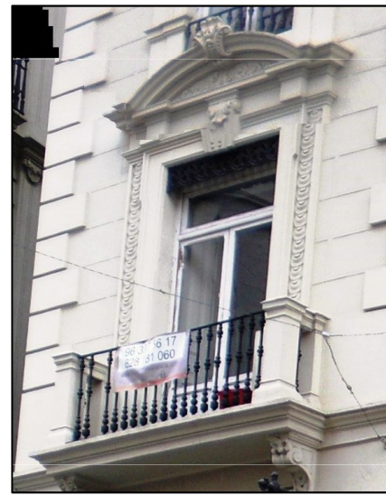
Hueco lateral Piso 2
