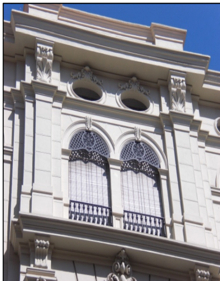
Hueco en fachada Planta 4
