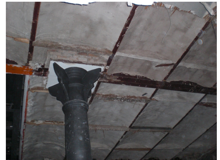
(Pilar planta baja con capitel de fundición.)
