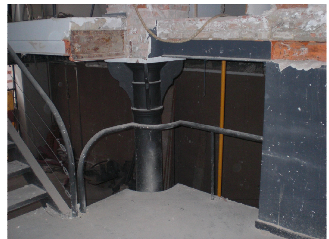
(Fotografía detalle vigas de perfiles IPN normalizados)
