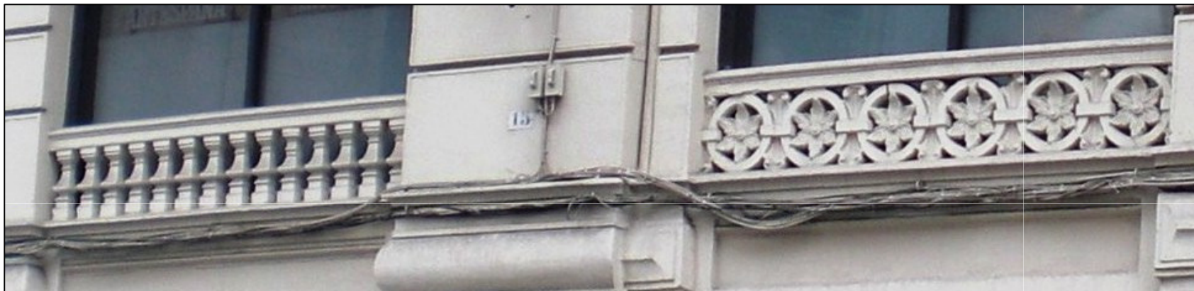
Balaustrada a modo de antepecho ubicado en la planta primera
