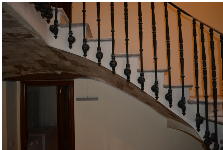
Detalle de la bóveda tabicada de la escalera
