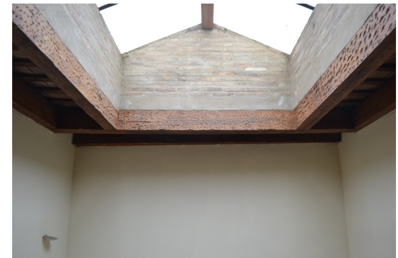
Detalle del lucernario que ilumina la caja de escalera
