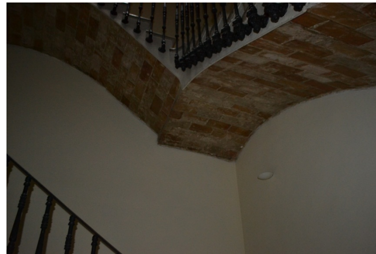
Detalle del rellano desde la parte inferior
