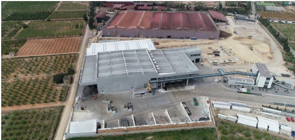
Imatge 6. Exterior de la Instal·lació 2E (Font: Pàgina web CRiV)
