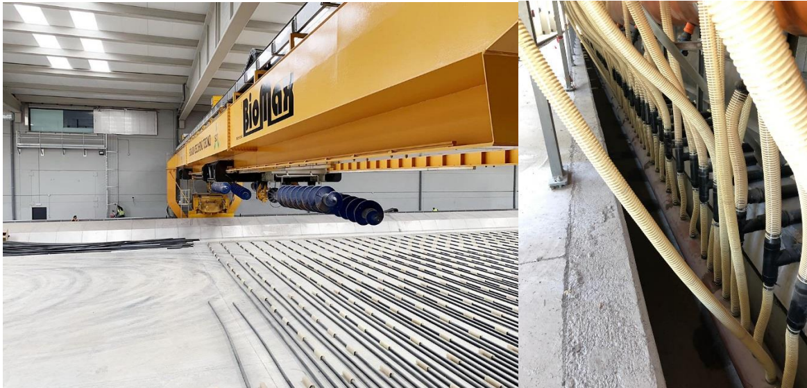
Imatge 30. Sistema d'aspiració d'aire en el llit del reactor (esquerra) i detall de les conduccions (dreta) Biofiltre (Font: pròpia web del CRiV i elaboració pròpia)
