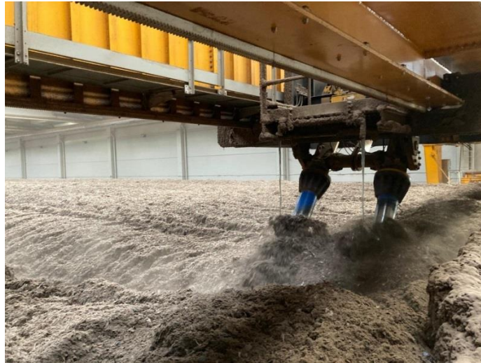
Imatge 31. Sistema de ruixat de llixiviats integrat en pont BIOMAX (Font: Elaboració pròpia)
