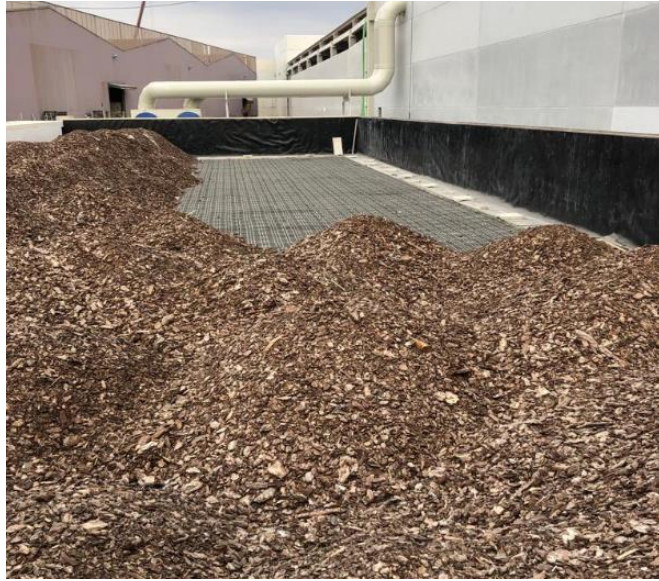
Imatge 32. Biofiltre (Font: Elaboració pròpia)
