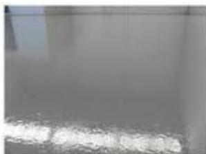
La rampa: se solará con terrazo “punta de diamante” de 30x30 cm. tomadas con mortero de cemento, dosificación 1:6
