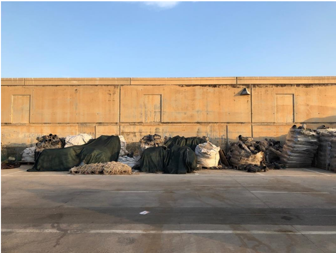
Imagen 2. Vista del espaldón a espaldas del dique.
