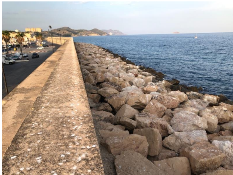
Imagen 1. Manto de escollera en el puerto de Villajoyosa.
