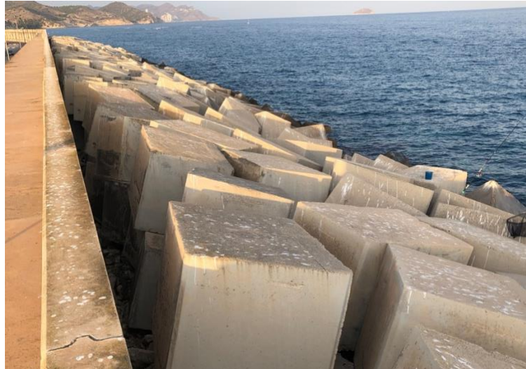
Imagen 10. Vista del tramo tres del puerto de Villajoyosa.
