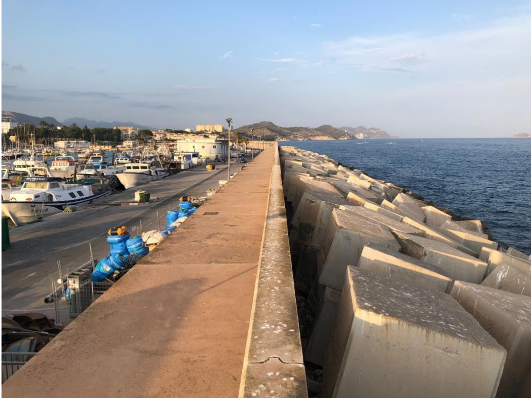
Imagen 7. Vista del tramo 3 del dique de Levante. Manto de bloques de hormigón.
