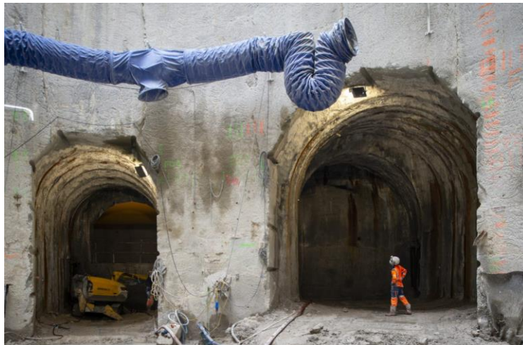
Figure 19: Rameau de secours et de ventilation
