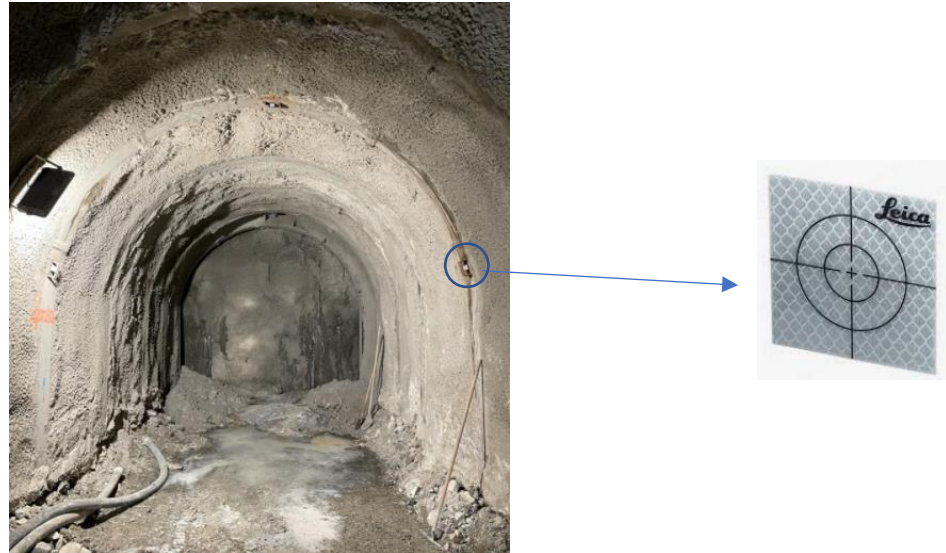
Figure 21: mesures des convergences
