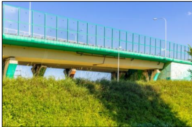
Figura 6. Pantalla acústica de vidrio transparente o traslucido
