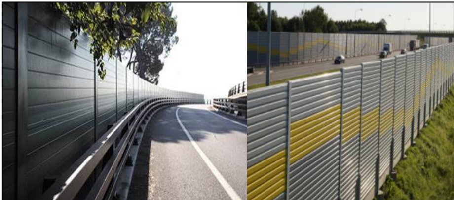
Figura 5. Ejemplos de pantallas acústicas metálicas
