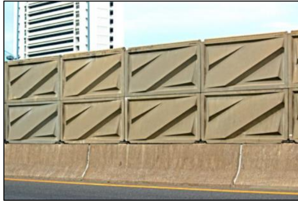
Figura 8. Pantalla acústica de hormigón
