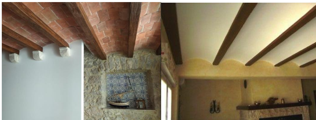
Figura 7. Fotos del forjado de revoltones de ladrillos bruto (izda.) y con revestimiento en el intradós (dcha.)
