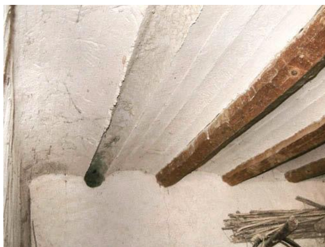
Figura 40. Forjado de revoltones sin vigueta.
