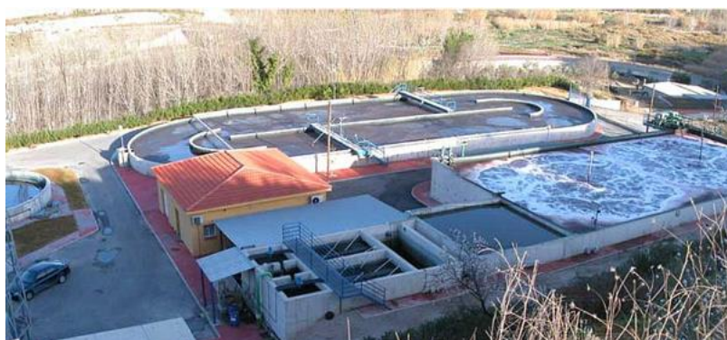
Imagen 9: vista general de la depuradora de agua.
