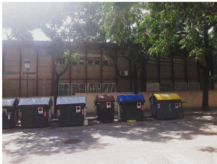
Ilustración 10. Fachada noroeste, Fuente: (Elaboración Propia)
