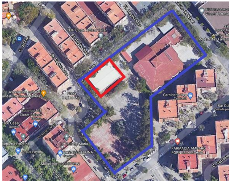
Ilustración 7. Ubicación del edificio objeto de estudio dentro de la parcela del colegio, Fuente: (Google Maps, s.f.)
