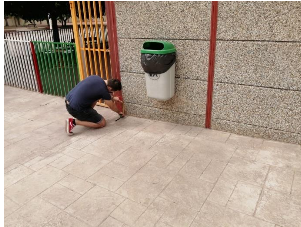
Ilustración 30. Medición espesor hormigón.
