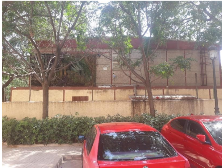
Ilustración 11. Fachada suroeste, con el Muro Vegetal incorporado, Fuente: (Elaboración Propia)
